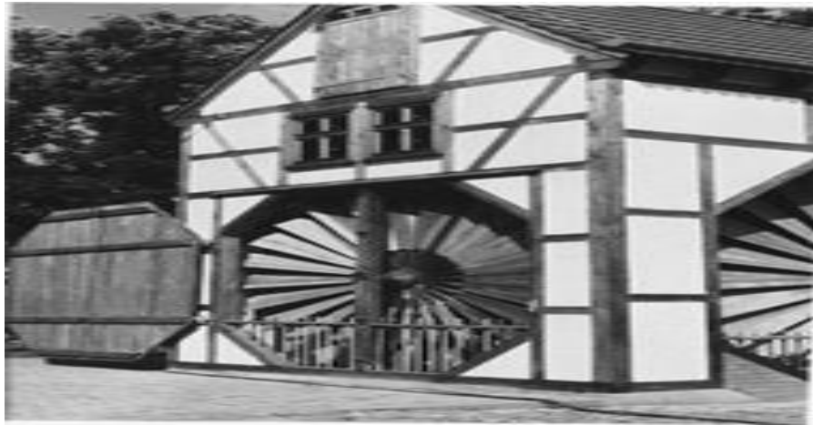
Şekil 1.1. Almanya'da, klasik örneklerinden farklı olarak pervaneleri binanın duvarlarında bulunan bir yel değirmeni [4]
