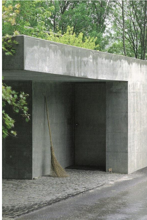
Görsel 25. Brüt betondan yapılmış kübik biçimli bir giriş saçağı.
