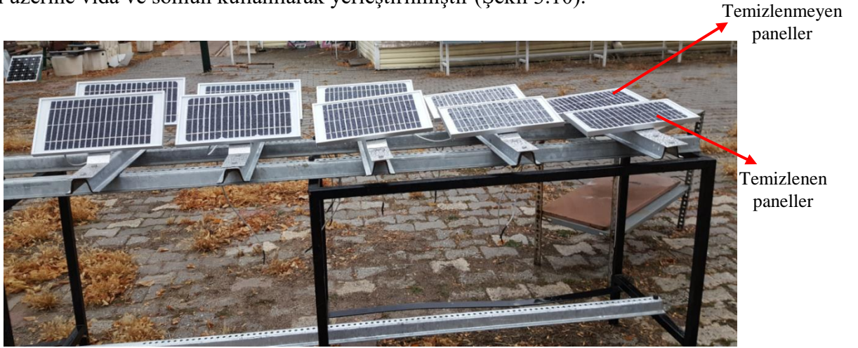
Şekil 3.10: Panel kablolama işlemi sonrası taşıyıcı sistemin görünümü
