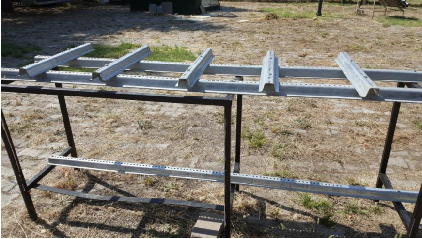
Şekil 3.5: Panel-taşıyıcı sistem bağlantı elemanlarının yerleştirilmesi
