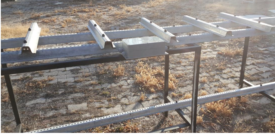
Şekil 3.8: Bağlantı kutusunun taşıyıcı sistem üzerine montajı
