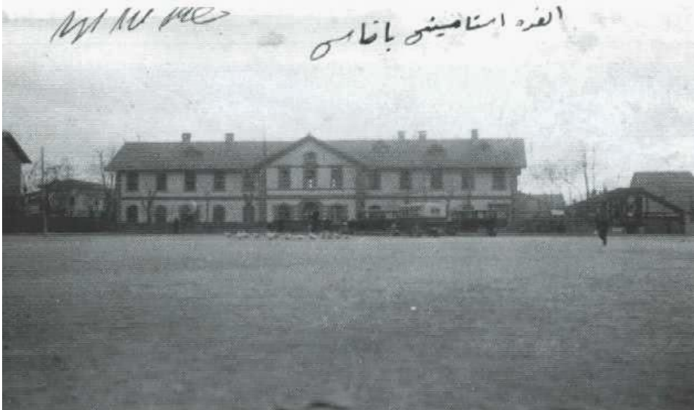
Resim 5. İki Katlı İstasyon Binası–yoldan görünüş (1910)
