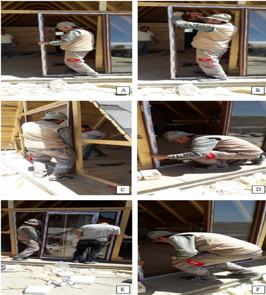
Şekil 31. Firma 3 Bungalov Ev Kapı Montajı İşlemi 1. Çalışana Ait Görseller.
