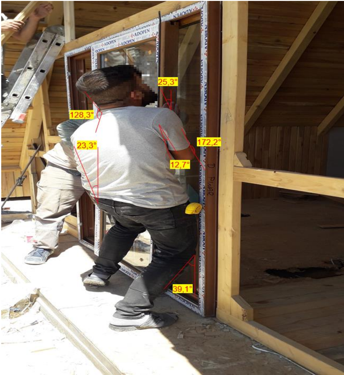
Şekil 34. Firma 3: Bungalov Ev Kapı Montajı İşlemi 2. Çalışana Ait En Riskli Çalışma Pozisyonları.
