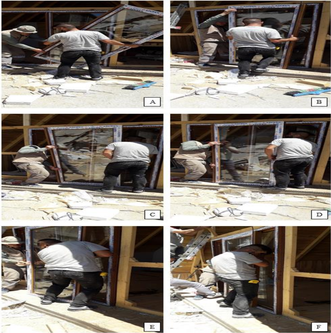
Şekil 33. Firma 3: Bungalov Ev Kapı Montajı İşlemi 2. Çalışana Ait Görseller
