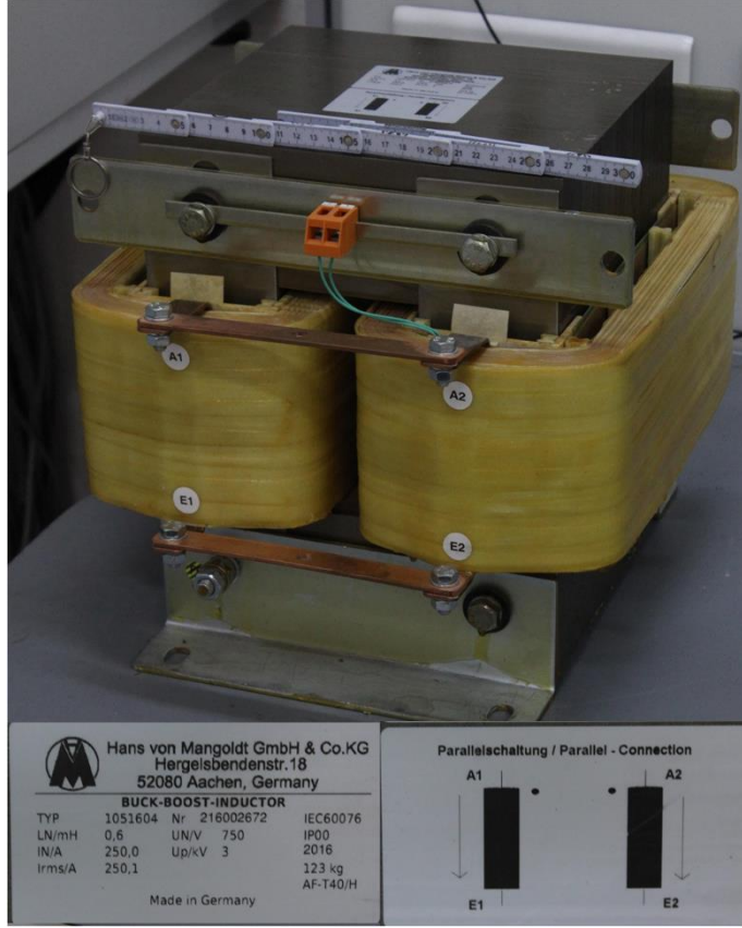
Şekil 2.15. İndirici ve Yükseltici Çevirgeç Devresinde Tasarlanan, Satınalınan ve Kullanılan Demir Nüveli Reaktör
