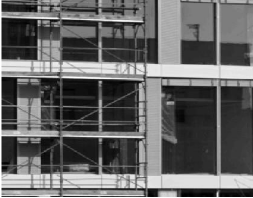
Şekil 20: Bina ve önündeki iskele
