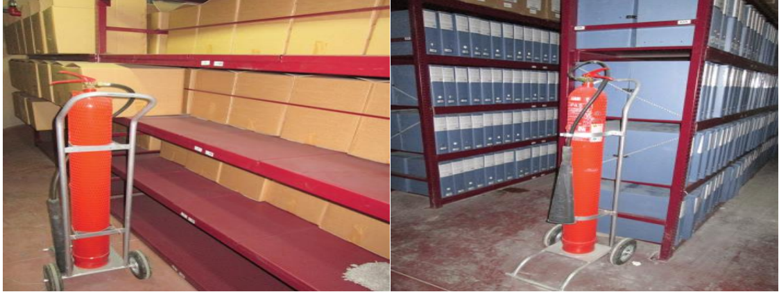
Fotoğraf 15. Hareketli yangın söndürücülerini (Kuzucuoğlu, 2014c)
