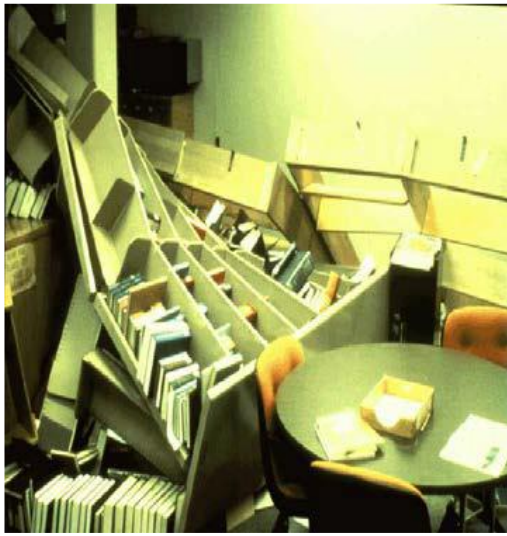
Fotoğraf 2. 1980 Livermore Depremi Lawrence Livermore Kütüphanesi'ndeki yapısal olmayan hasar (Aktaran Kuzucuoğlu, 2015, s. 6)
