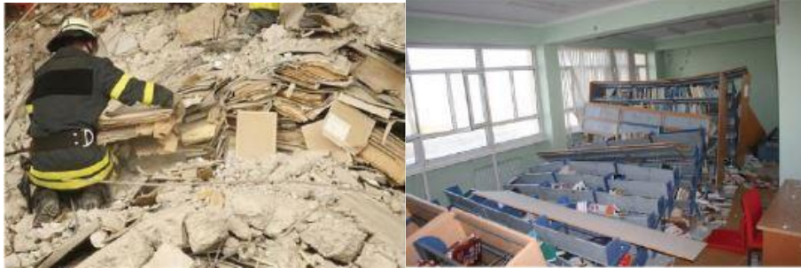
Fotoğraf 5. Köln Arşiv Binasının çökmesi sonucu arşivlerde meydana gelen hasar (solda)-Van Yüzüncü Yıl Üniversitesi Ferit Melen Kütüphanesinde meydana gelen deprem hasarı (sağda) (Aktaran Kuzucuoğlu, 2014a, s. 341)
