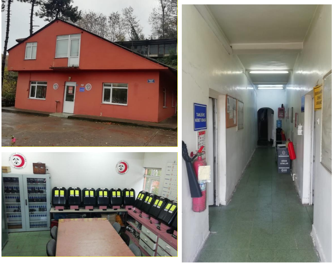
Şekil 2.19. TTK Karadon Tahlisiye İstasyonu genel görünümü *
