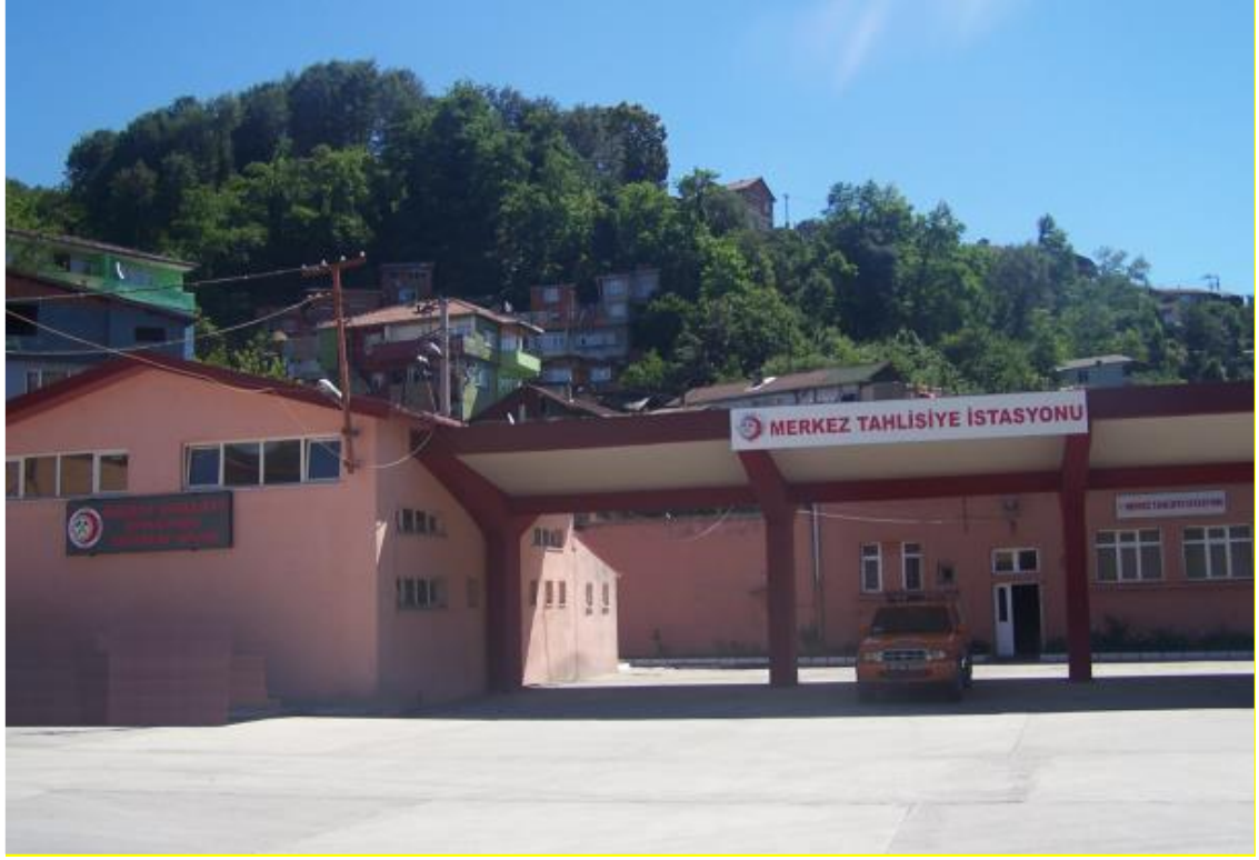
Şekil 2.18. TTK Merkez Tahliye İstasyonu genel görünümü (7)
