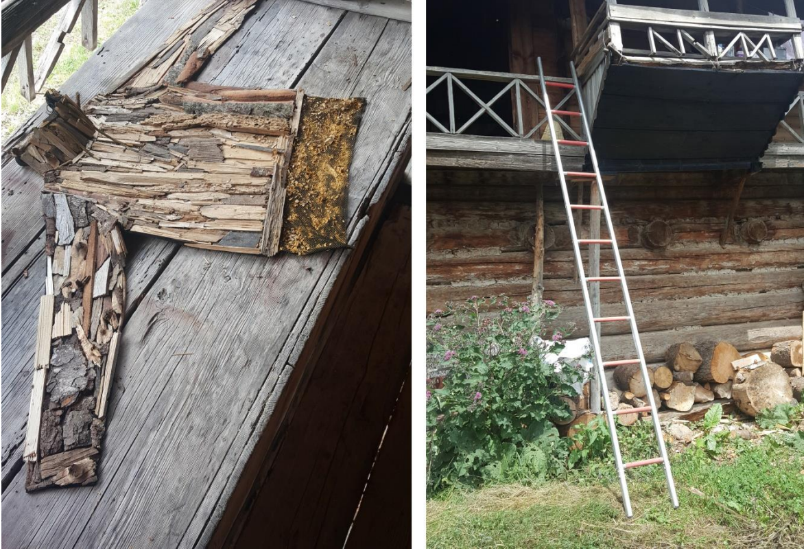
Görsel 59. Zeynep Merve Çiçek Mızrak. Dış-la-ma. 2019. (Yapım Aşaması)
