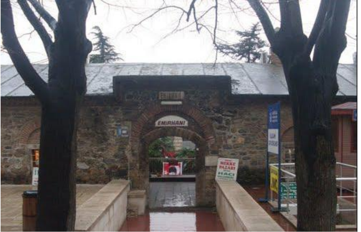
Resim 57: Emir Han giriş kapısı
