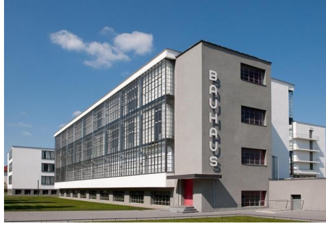
Görsel 49. Bauhaus binası Erişim: 17.12.2020 https://www.themaggar.com/bauhaus-nedir/
