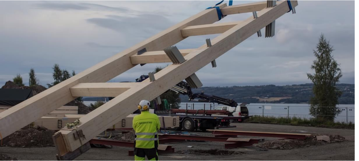
Şekil 9.25. : Fabrikadan montaj için hazır halde gelen yapı malzemeleri [96].
