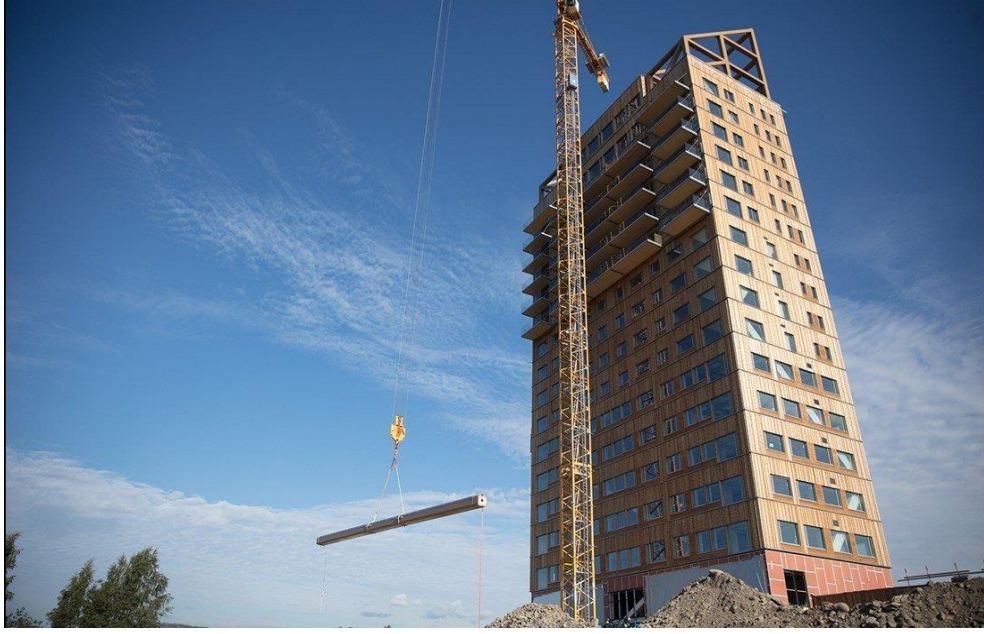
Şekil 10.10. : Fabrikasyondan gelen malzemelerin yerine montaj işlemi yapılırken- Mjos( Mjøstårnet) Tower, Norveç şantiye alanından vinçle malzeme taşıma [109].
