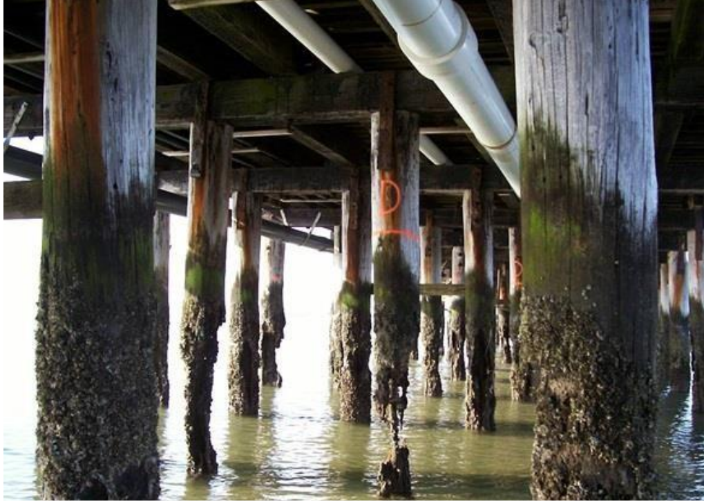
Şekil 3.6. : Deniz zararlılarının ahşap malzemeye verdiği hasar [17].
