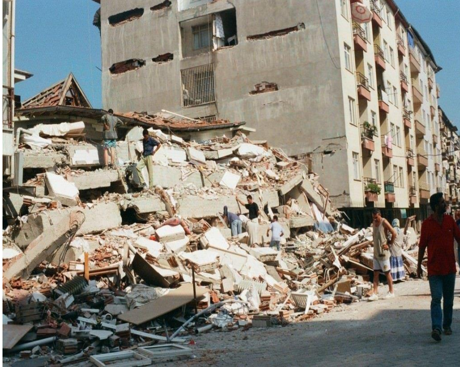
Şekil 10.3. : Marmara Depremi,kolonları patlayan ve tabliyelerin üst üste geldiği bir yapı [102].
