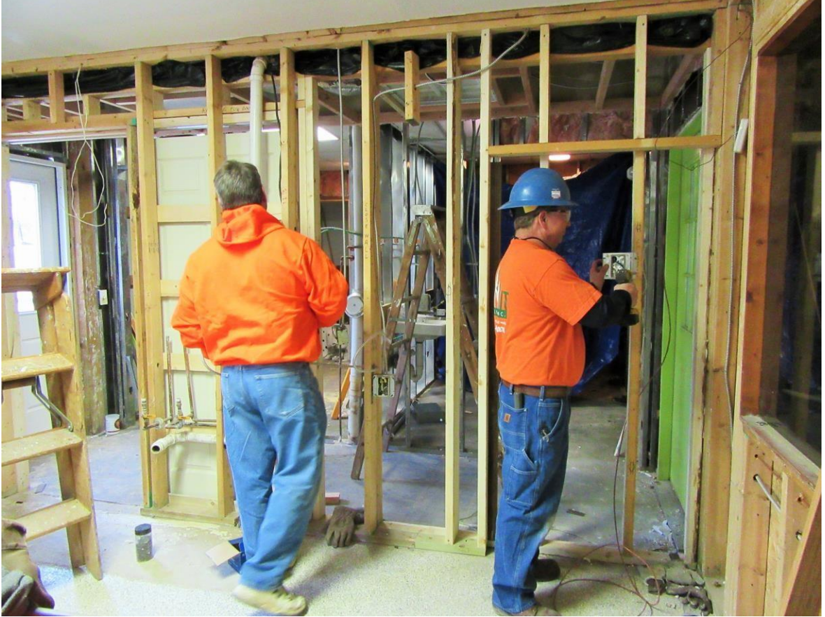
Şekil 10.9. : Olası bir kısmi onarım durumunda; ahşap yapıda herhangi bir parçanın diğer yapılara göre daha kolay ve ekonomik değiştirilebilir [108].
