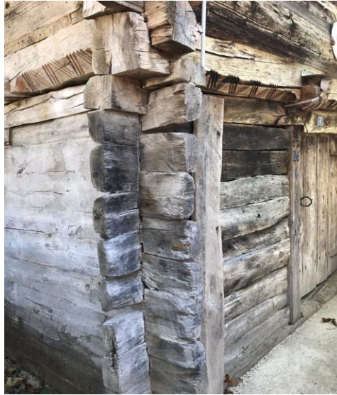
Şekil 7.2. : Yığma ahşap (çanti yapılar) daki köşe geçmeleri [51].
