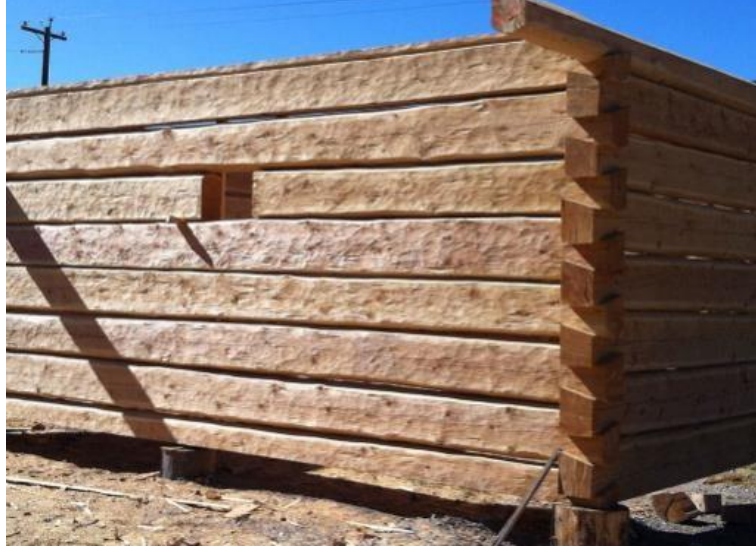
Şekil 5.8. : Dişli bağlantı ile yapılmış ahşap bir yapı [42].
