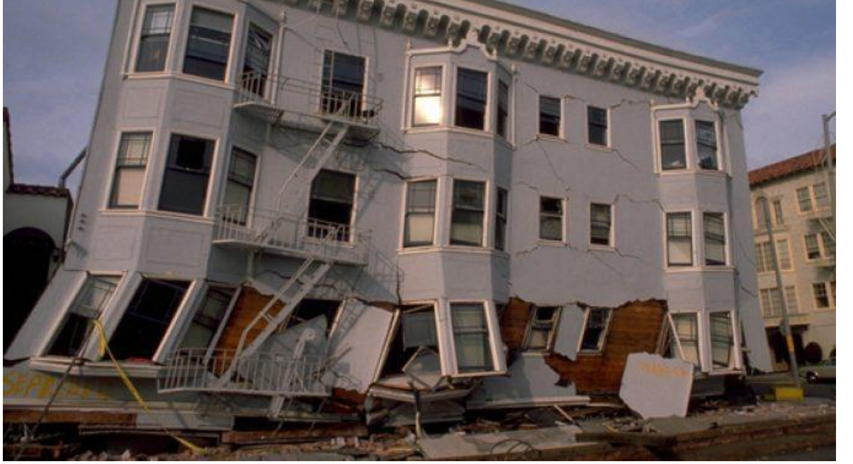
Şekil 10.4. : Hindistan'da deprem sonrasında ahşap konstrüksiyon bir konut [103].
