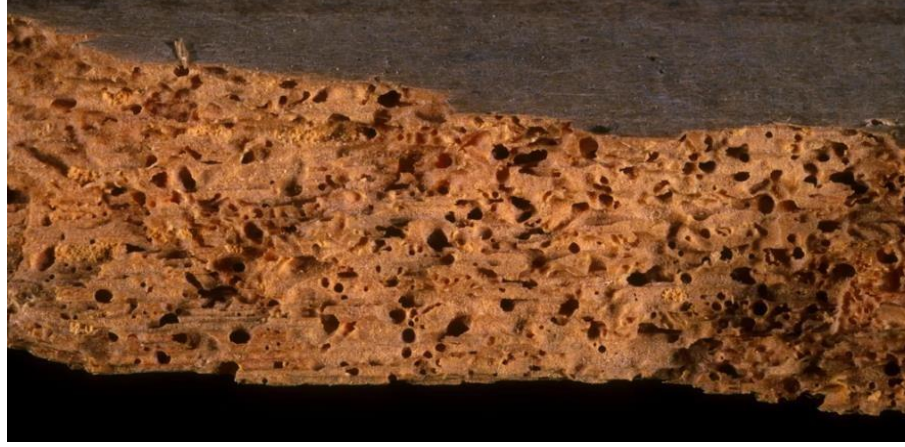
Şekil 3.4. : Ahşap yapıya böceklerin verdikleri hasar [14].
