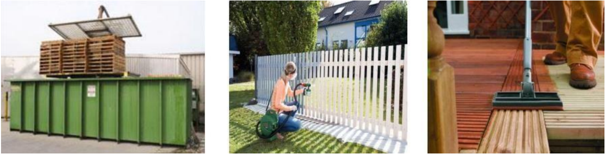
Şekil 3.8. : Batırma-püskürtme,fırça ile sürme empenye metotları [12].
