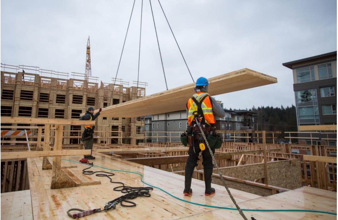
Şekil 10.11. : Montaj kolaylığı ve hız sağlayan ahşap yapı karesi (Adera firmasının şantiyelerinden bir kare) [110].
