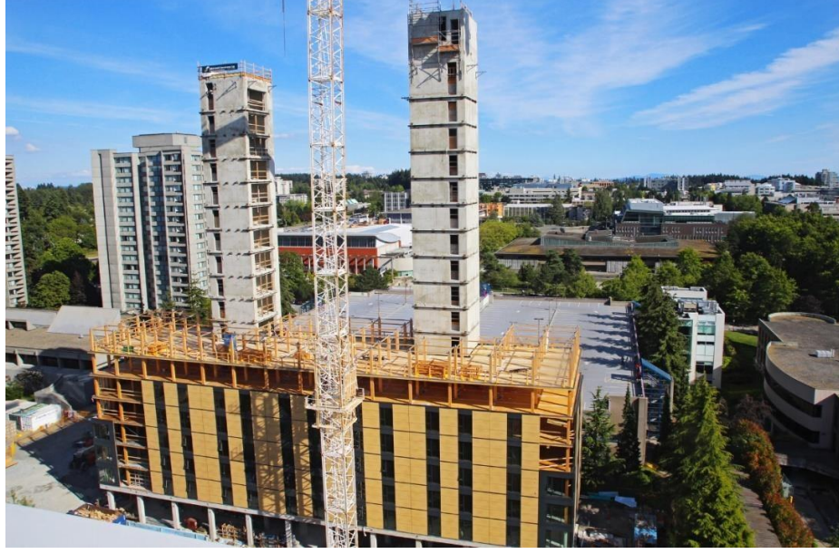
Şekil 9.19. : UBC Student Residence, Kanada- inşaat aşamasında şantiyeden çekilen bir kare [91].
