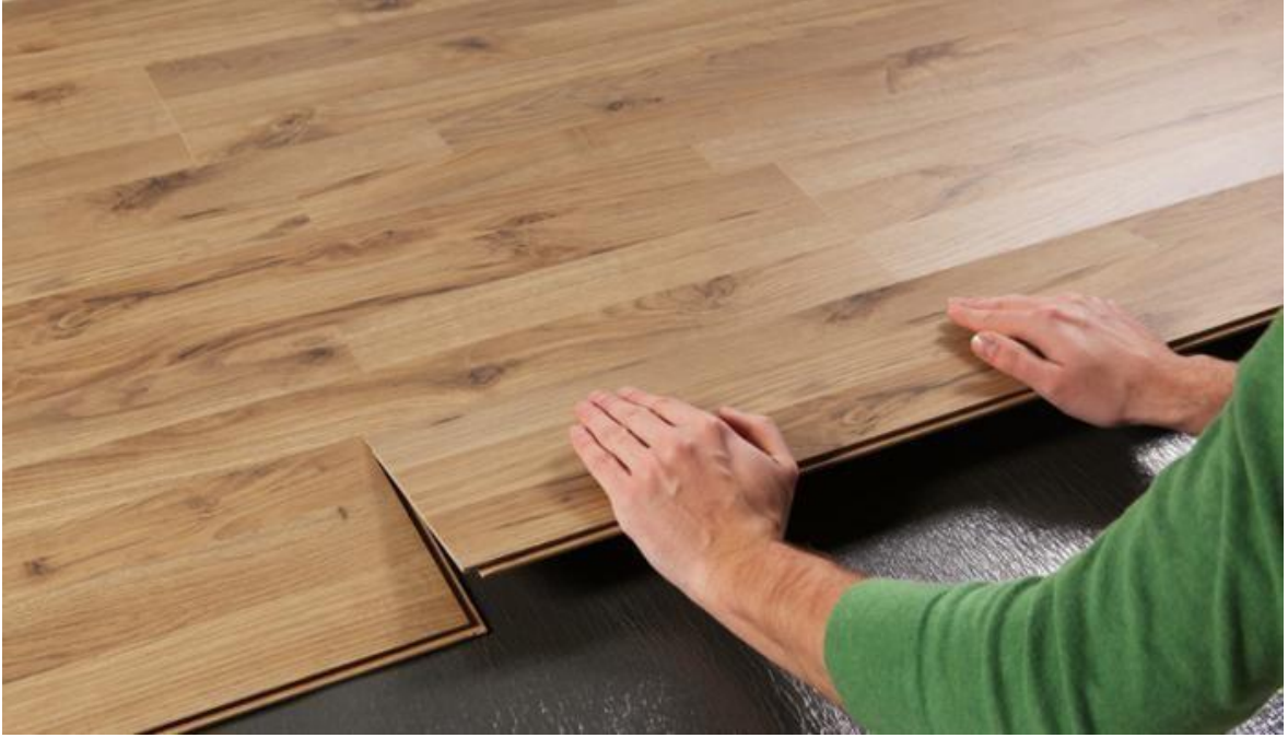
Şekil 5.5. : Ahşap parkede geçmeli lamba-zıvana birleşimi [41].
