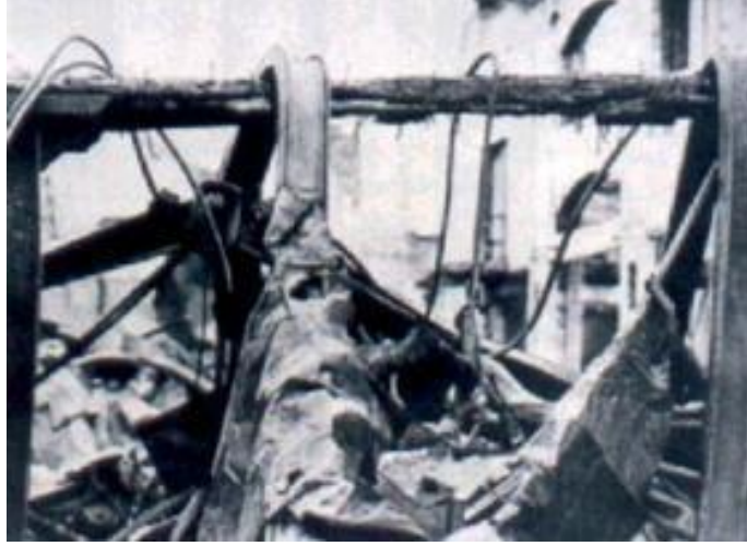
Şekil 10.1. : Yangın sonrasında ahşap ve çelikler [97].
