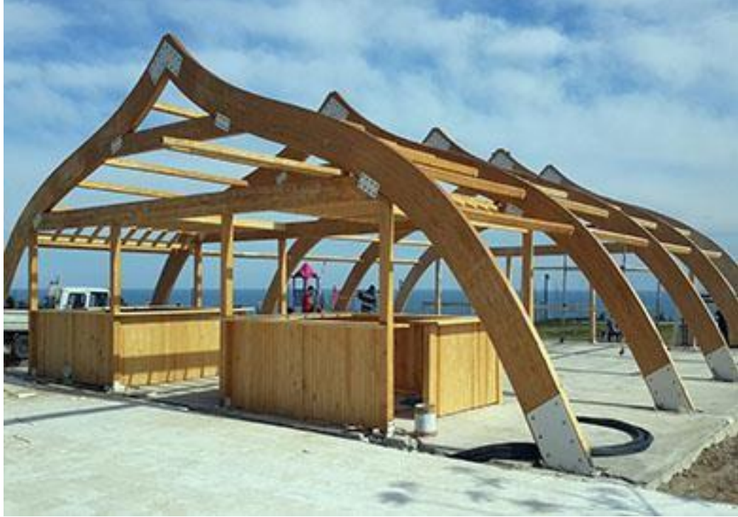
Şekil 10.8. : Ahşabın laminasyon tekniği uygulanarak kolay şekil verilebilirliği [107].
