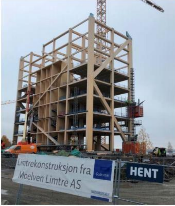
Şekil 9.24. : Mjos( Mjøstårnet) Tower, Norveç-şantiye alanından inşaat aşamasında çekilen kareler [95].
