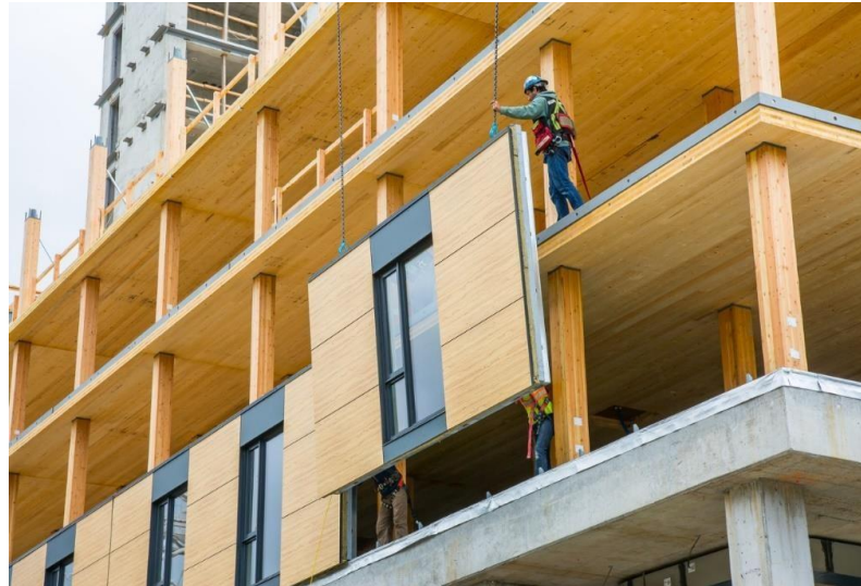
Şekil 9.20. : UBC Student Residence, Kanada- yapının dış cephesi takılırken bir kare [91].
