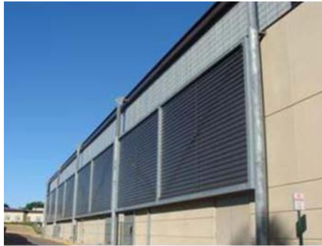
Şekil 4.4. Break kolejinin güney batı cephesine kurulmuş güneş duvarı [29]
