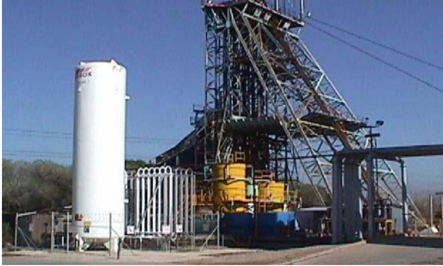
Şekil 2.2. Maden atık suyu arıtma tesisi (Güney Afrika)
