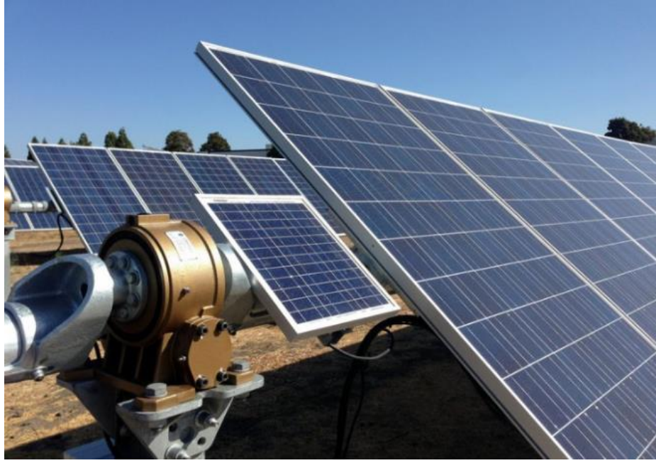
Şekil 2.6. Tek eksenli otomatik bir güneş izlemeli sistem[8]
