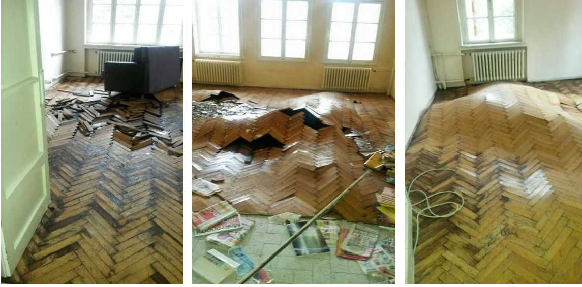
Görsel 4.45: Yalıtımsız Kalan Yapılarda Parke Döşemelerde Oluşan Hasarlardan Bazıları, 2018, Namık Kemal Mahallesi Koruma ve Yaşatma Derneği Arşivinden
