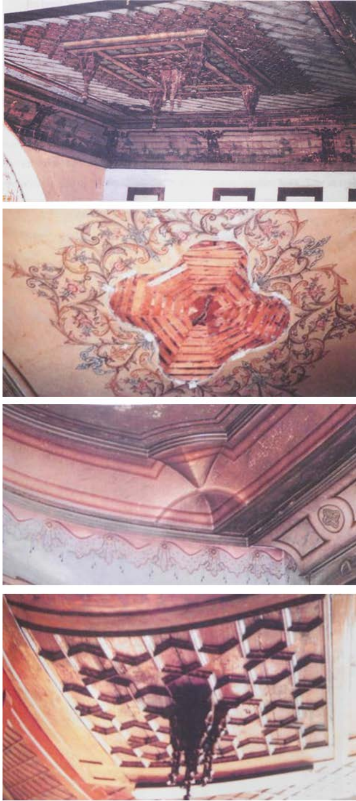
Şekil 12. İncelemesi yapılan yapının süslü ahşap tavan görseli (Demir, 1996)
