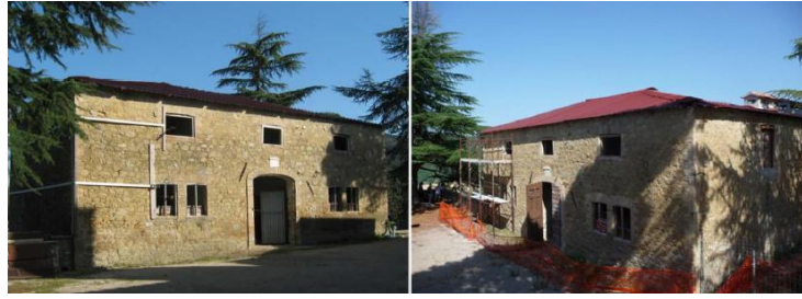
Şekil 41: Tarihi yapının cephe görünümü (Pertosa et al., 2014)
