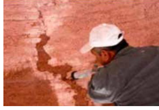
Resim 14: Fatih Camii restorasyonunda çatlakların enjeksiyon ile onarılması
