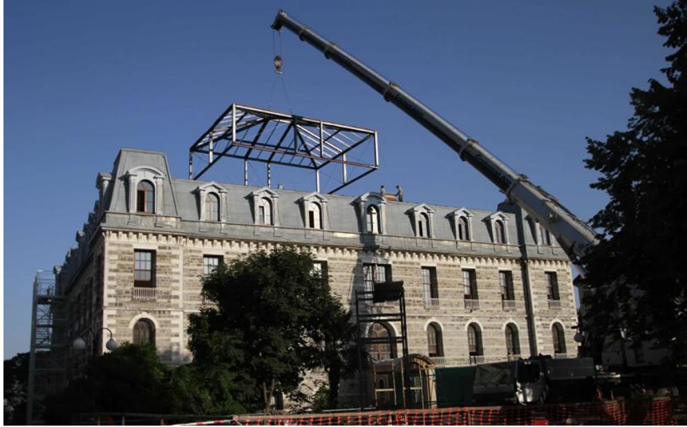
Resim 66: Tavan camının uygulanma anı (Yapı İşleri, 2010)
