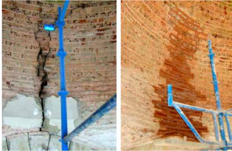
Resim 15: Fatih Camii restorasyonu sırasında yapılan dikiş uygulaması
