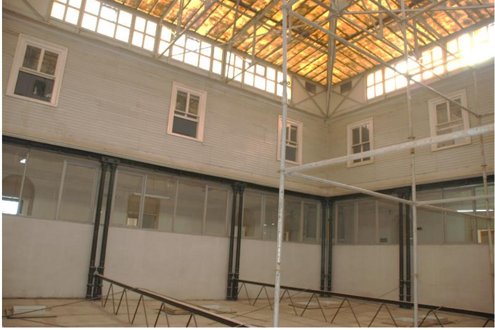
Resim 65: Tavanın renovasyon öncesi durumu (Yapı İşleri, 2010)
