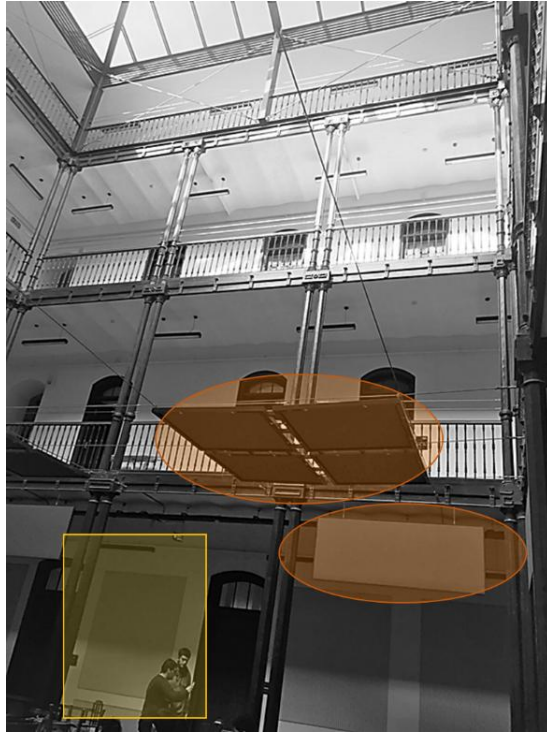
Resim 54: Zemin kat akustik uygulamaları (Begüm Gökdağ Arşivi, 2018)
