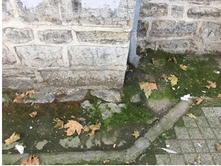
Resim 89: Yapının kenarında oluşan yosunlaşma (Begüm Gökdağ Arşivi, 2018)
