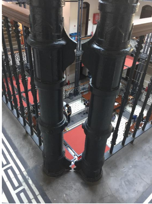
Resim 58: Dökme demir taşıyıcı detayı (Begüm Gökdağ Arşivi, 2018)
