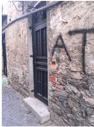
Resim 82: Yapı ile istinat duvarı arasında kalan koridor kısmında boyanmış olan duvar (Begüm Gökdağ Arşivi, 2018)
