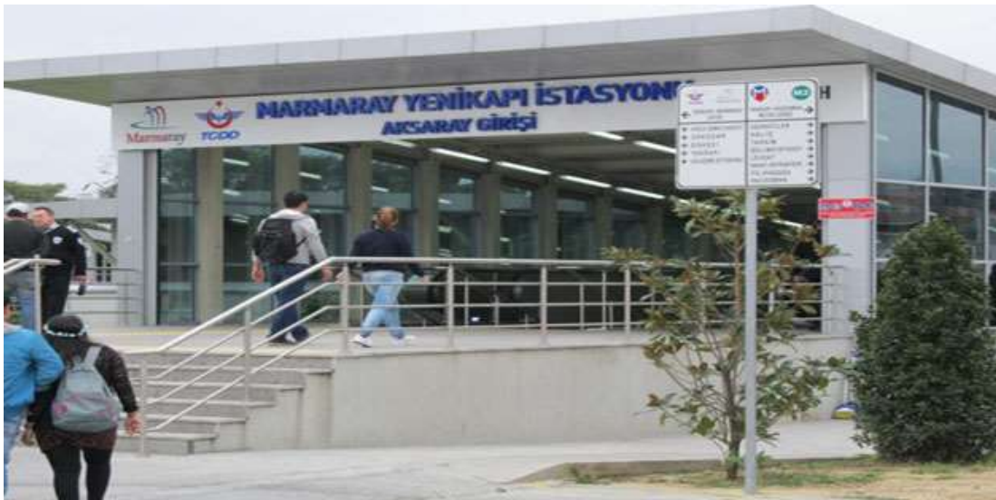
Görsel 90 b) Yenikapı istasyon girişi.
