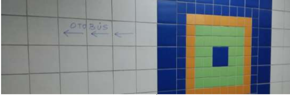
Görsel 111 a) Koru İstasyonu duvarı.
