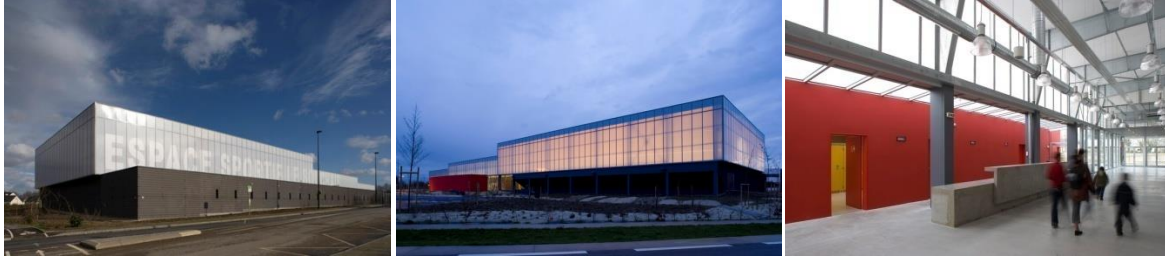
Resim 67. Souchais Spor Kompleksi, Carquefou, Fransa, Aerojel dolgulı çok tabakalı polikarbonat panellerden oluşturulmuş dış duvar yüzeyleri ve iç mekan görüntüleri, Murail Architectures, 2006 (Altın, Aşıkođlu, 2014).
