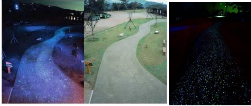
Resim 51. Fosforlu cam parçacıkları ve diğer ışık saçan bileşenleri ile ayak izi örtüsü: Maya Mountain Caddesi, Kobe, Kirakira-Komichi.(URL-27)
