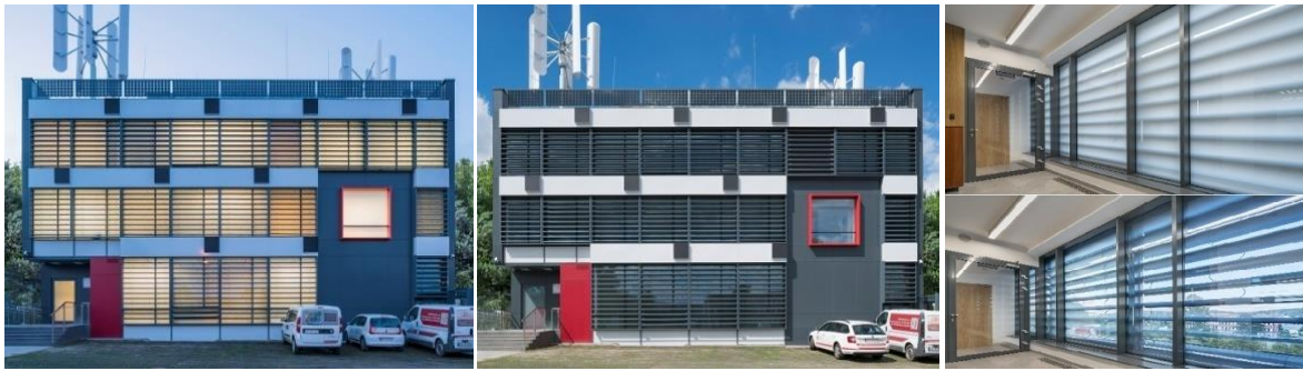
Resim 86. Akıllı Malzeme Cephe Sistemi, Elektro-optik likid kristal opak ve şeffaf faz görünümleri, DLJM Lab, Kraków, Polonya (URL-59).
