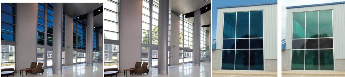
Resim 77. a) Elektrokromik Kaplamalar: Renkli ve renksiz görüntüleri; b) Güneş ışığına duyarlı Termokromik camlar: Pencere doğrudan güneş ışığı ile renklendirilmiştir; pencere sadece dolaylı güneş ışığına maruz kaldıklarından daha nettir (Savić, vd., 2013).
