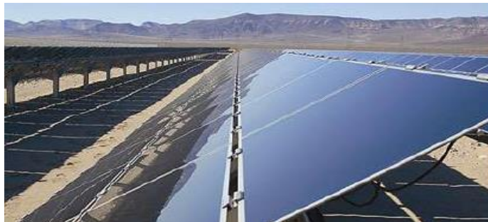
Resim 91. Güney Batı'da Bir Alan Kurulumunda Solar İnce Film Modülleri, Eldorado, ABD, (2011) (Fraas, 2014).
