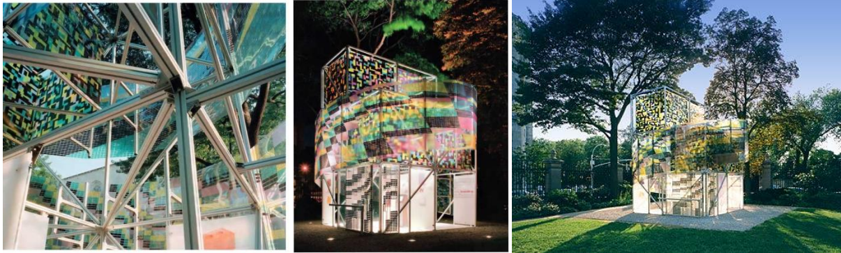
Resim 54. Smartwrap: Polysmart uygulama ışık yayan ve ısı depolayan akıllı malzemeler, Organik Işık Yayan Diotlar (OLED) ile Film, Organik Fotovoltaik Hücreler, Faz Değiştiren Malzemeler ile Film, Çok Katlı Bina Kabuğu ile Pavilyon, Kieran Timberlake Associates, Cooper Hewitt Ulusal Tasarım Müzesi, New York, ABD (2003) (URL- 29).
