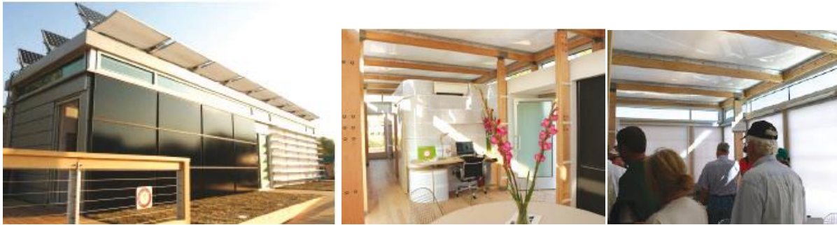
Resim 69. Solar Decathlon, Aerojel Dolgulu EFTE Kaplı Çatı Panelleri (iç-dış tavan yüzeyi), Georgia Üniversitesi Binası, ICARUS, ABD,2007 (Altın, Aşıkoğlu 2014).
