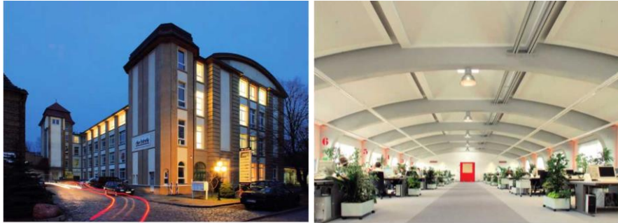
Resim 59. 'The Factory': Gaz / Su Depolayan Akıllı Malzeme, Zeolitli Alçıpan Levhalar, Ses Emme ve Hava Temizleme, Çok fonksiyonlu katalitik alçı pano tavan endüstriyel anıt, Marco Duchow, Alexander Duchow Cottbus, Almanya, 2005.
