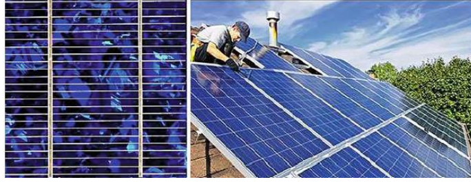
Resim 90. Tek Bir Polikristalin Silikon PV Hücresi: Hücre izgara hatlarını ve çoklu kristalleri gösterir (solda) ve bir ev çatısına birkaç modül yerleştirilmesi (sağda) (Fraas, 2014).
