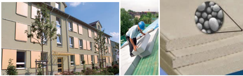
Resim 75. 3 Litre Evi, PCM Yalıtım Malzemesi: Brunck Mahallesi'ndeki konut modernizasyon projesi, Ludwigshafen, Almanya, 2001 (URL-49).
