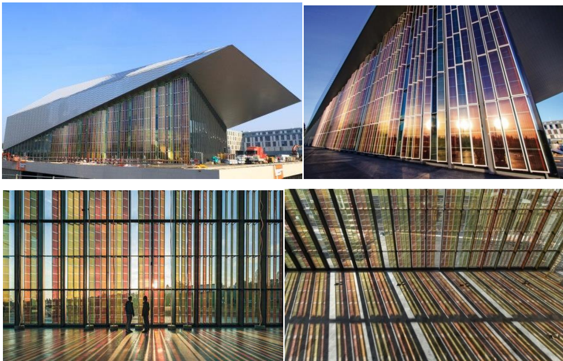
Resim92. SwissTech Kongre Merkezi:Renkleri, Solaronix tarafından yapılan panellerde cepheye entegre edilen boya duyarlı güneş hücrelerinden gelmektedir.Richter Dahl Rocha & Associés, İsviçre, 2014 (URL-62).
