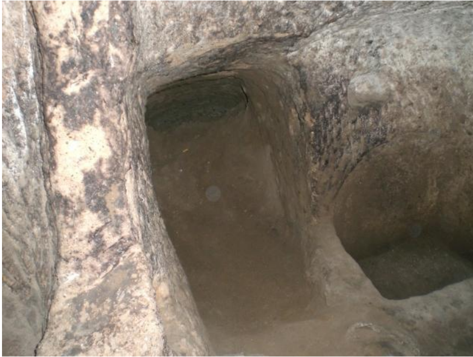
Şekil.2.9. Yeraltı şehirinde erozyon sonucu dolmuş geçit (Özgün)
