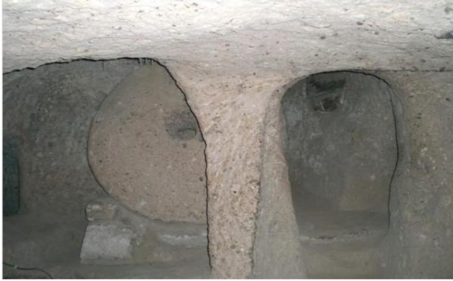
Şekil.2.12.Yeraltı Şehirlerinde tehlike anında koridorları kapatmaya yarayan sürgü taşı (Özgün)
