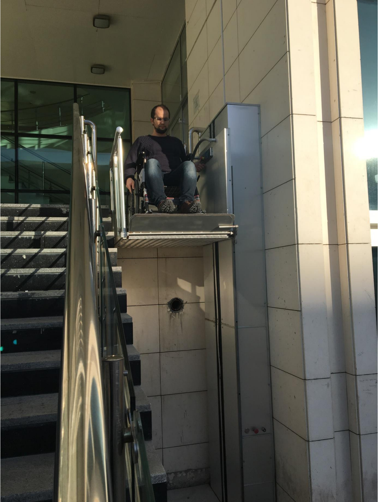
Merdiven asansörü uygulaması, fotoğraf no - 11
