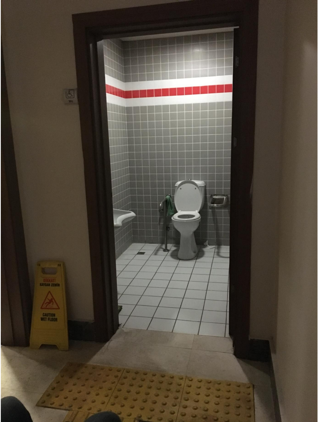
Bina içi uygulamalar - Engelli Tuvaleti, fotoğraf no - 1
