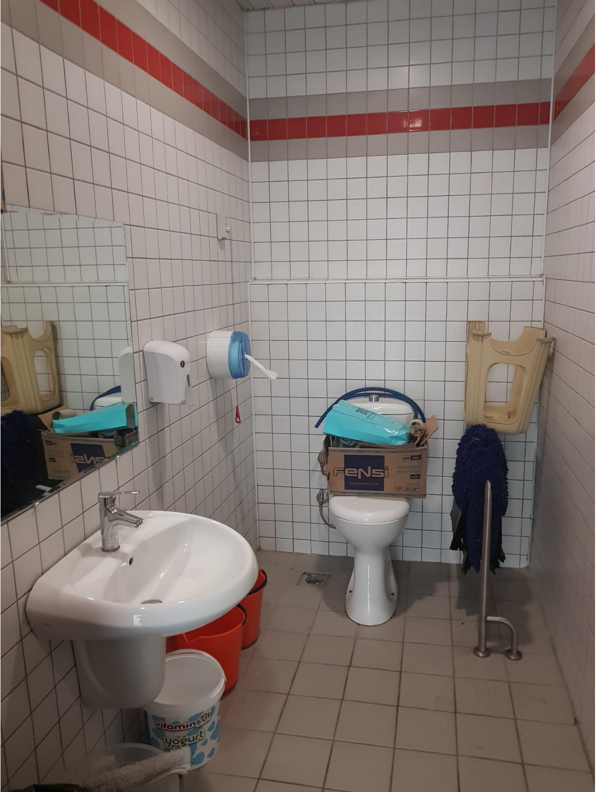
Bina içi uygulamalar - Engelli Tuvaleti, fotoğraf no - 12
