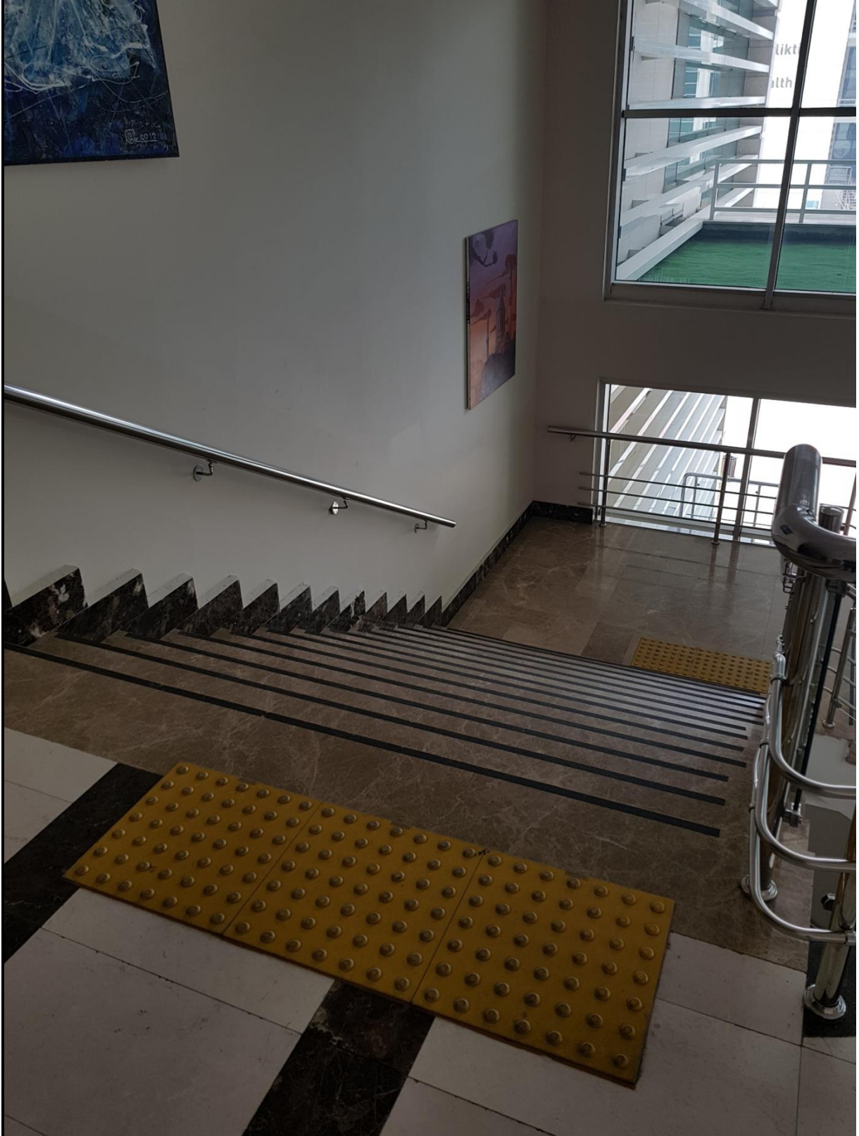
Bina içi düşey dolaşım - Merdiven, fotoğraf no - 3
