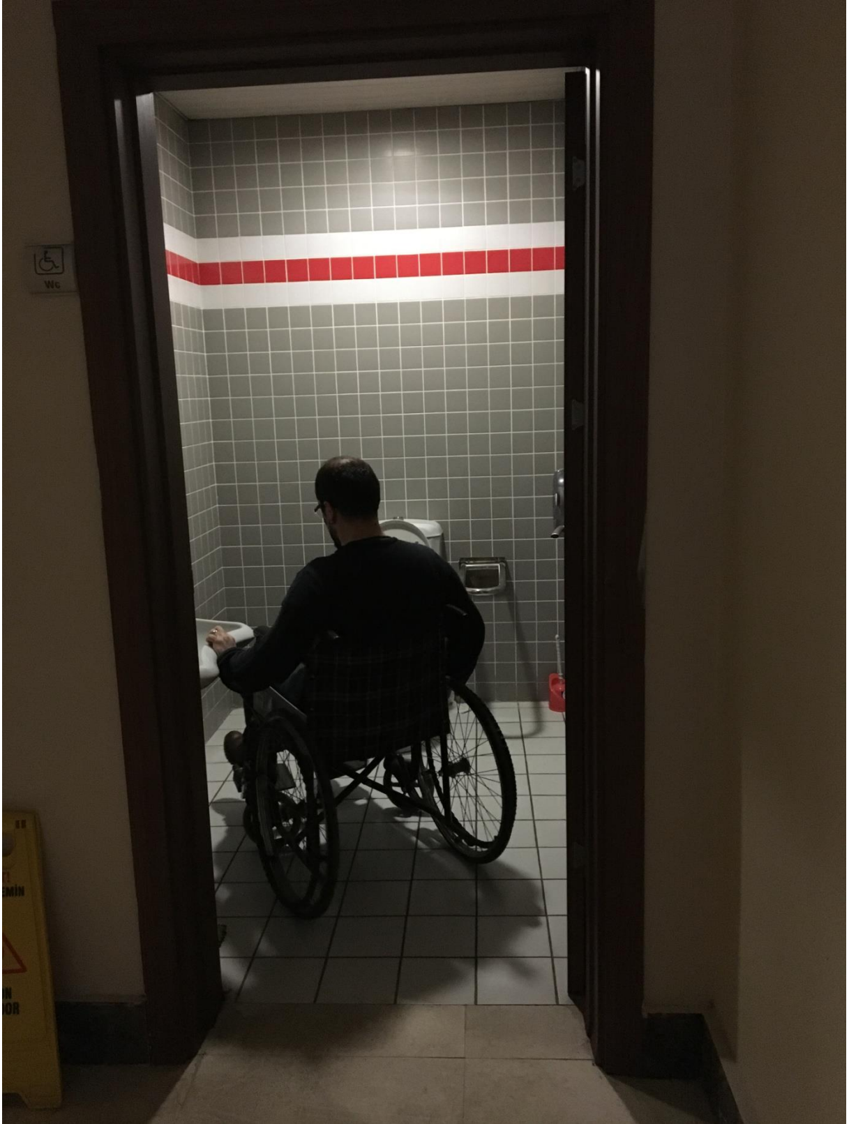
Bina içi uygulamalar - Engelli Tuvaleti, fotoğraf no - 5
