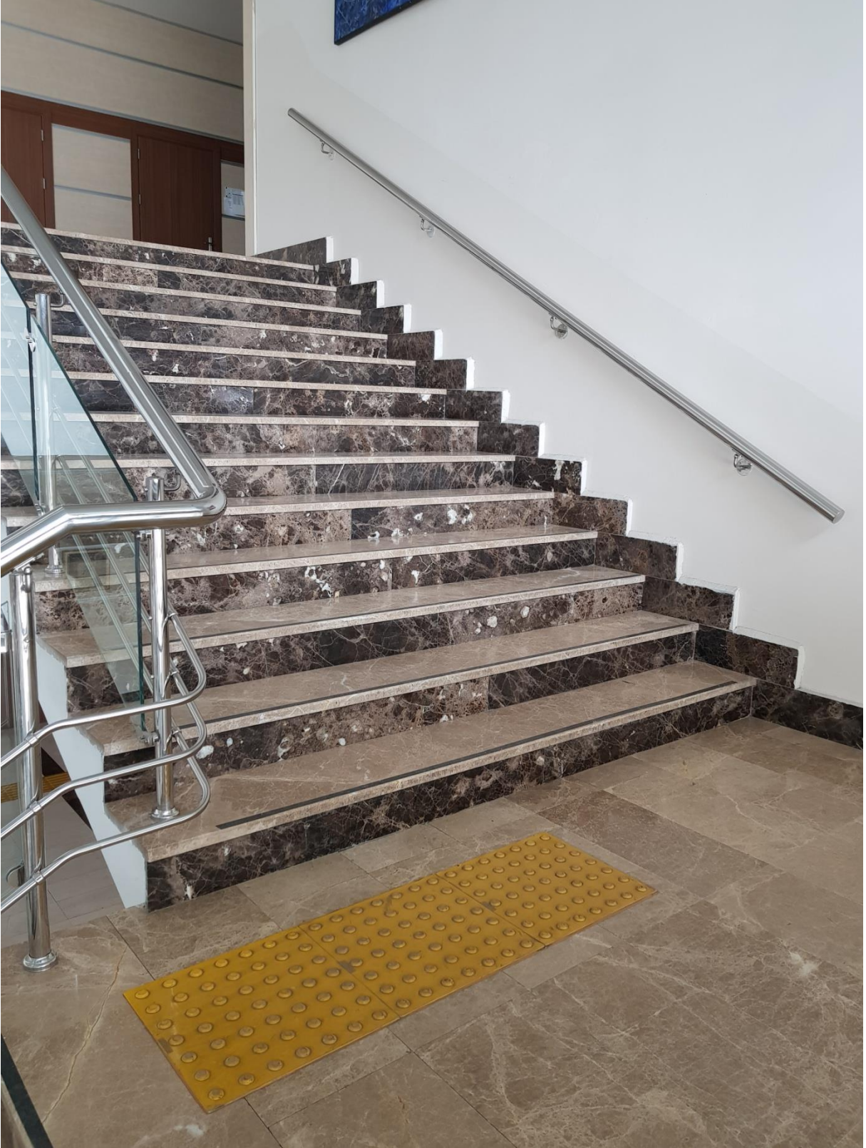
Bina içi düşey dolaşım - Merdiven, fotoğraf no - 2
