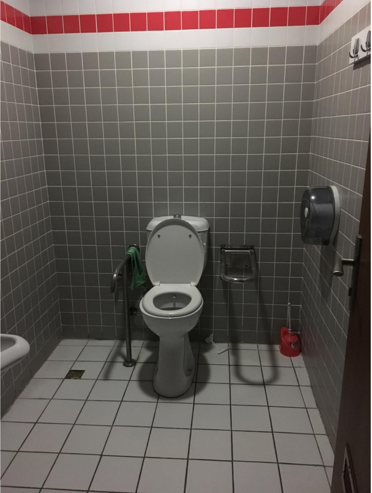
Bina içi uygulamalar - Engelli Tuvaleti, fotoğraf no - 2
