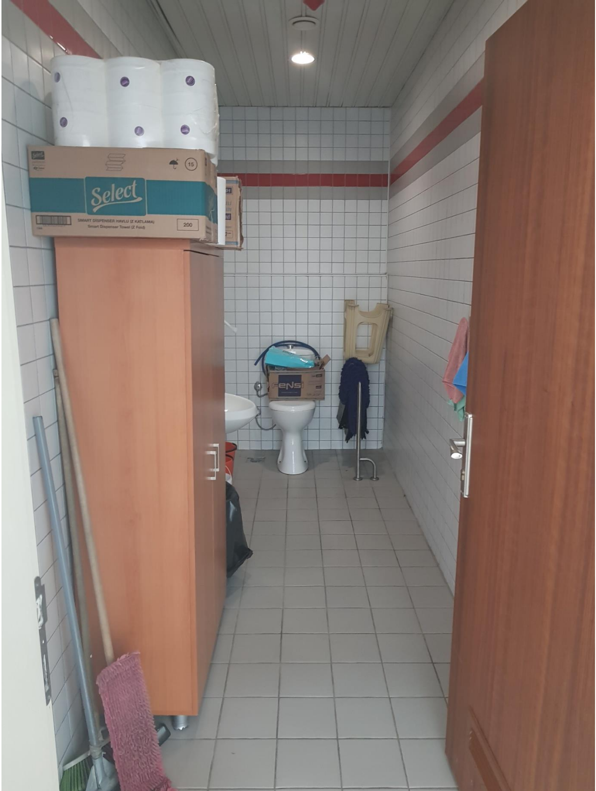
Bina içi uygulamalar - Engelli Tuvaleti, fotoğraf no - 11
