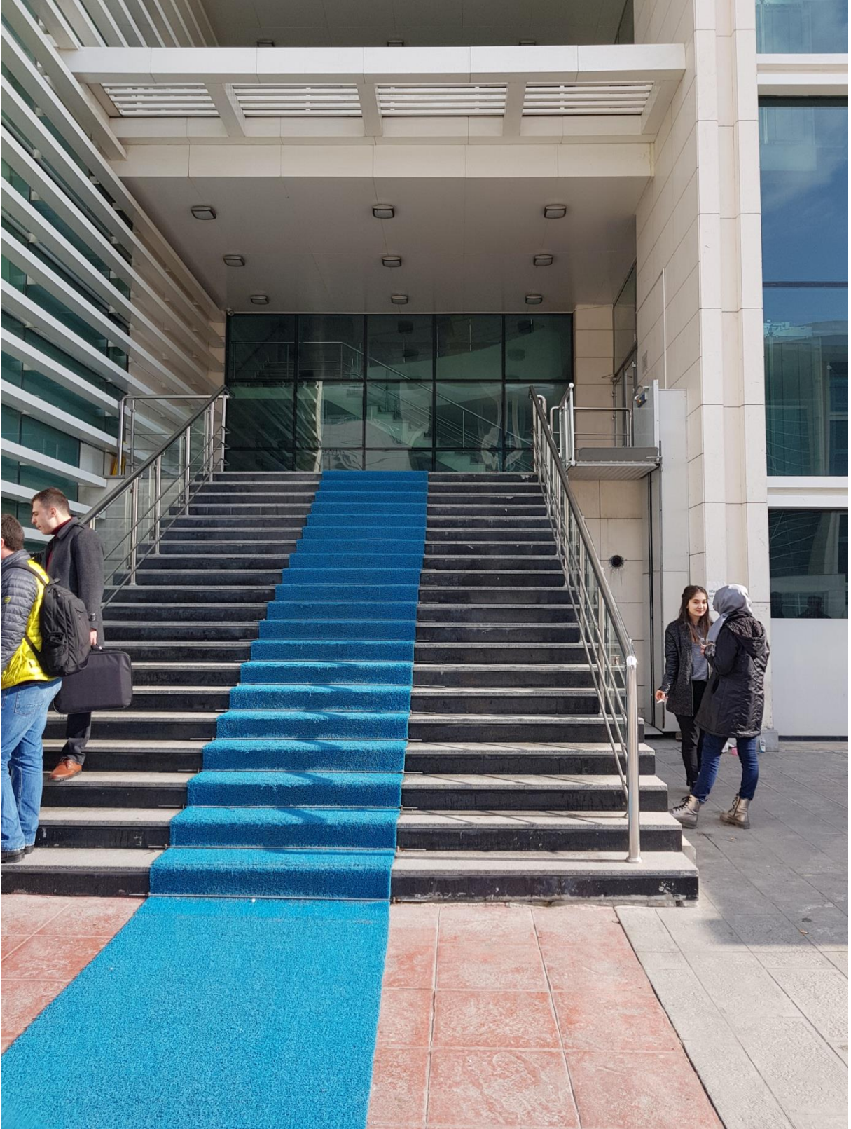
Merdiven asansörü uygulaması, fotoğraf no - 7
