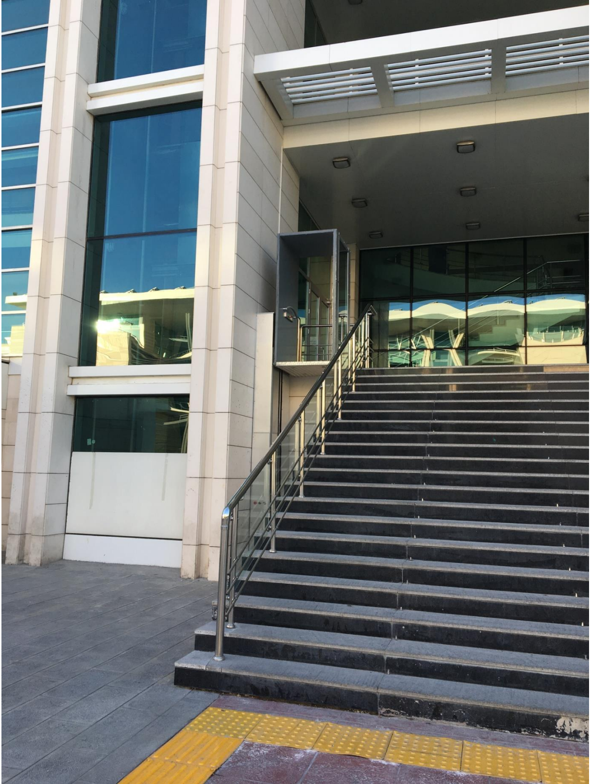
Merdiven asansörü uygulaması, fotoğraf no - 18
