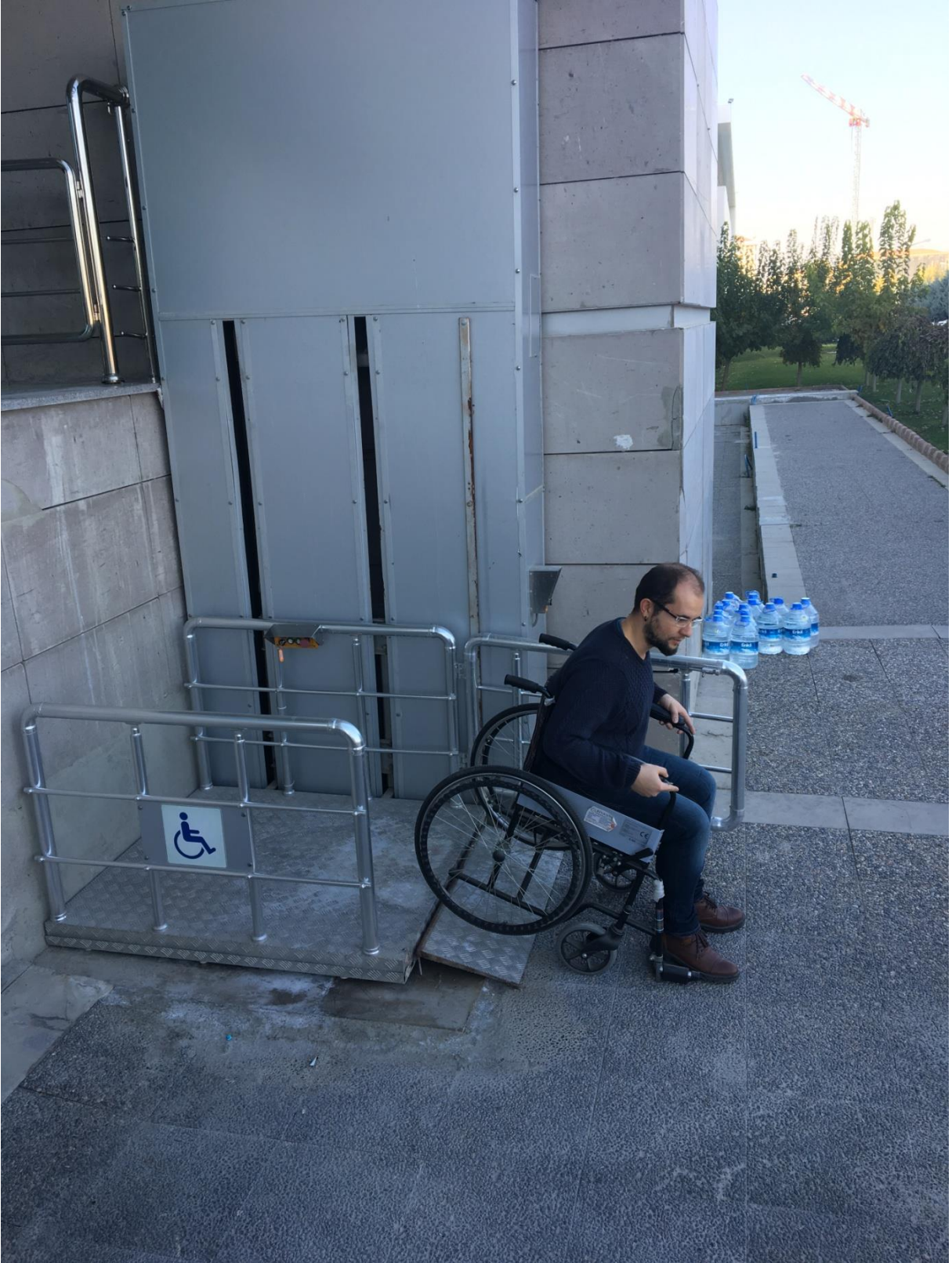
Merdiven asansörü uygulaması, fotoğraf no - 6
