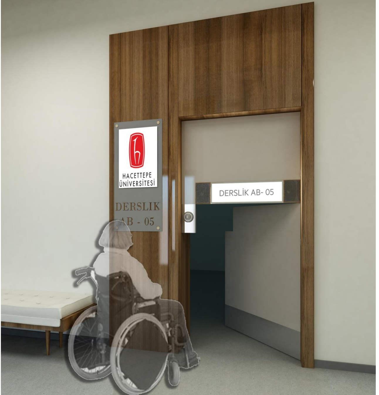
İç mekan engelsiz kapı tasarımı - üst kanat kapalı, alt kanat açık, görsel no.3
