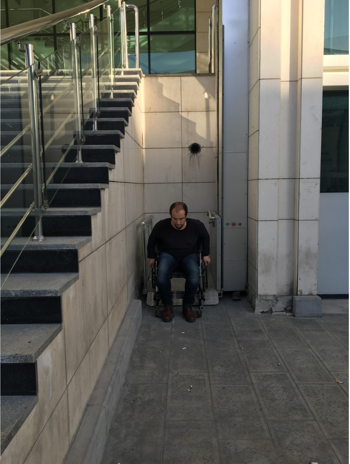
Merdiven asansörü uygulaması, fotoğraf no - 16
