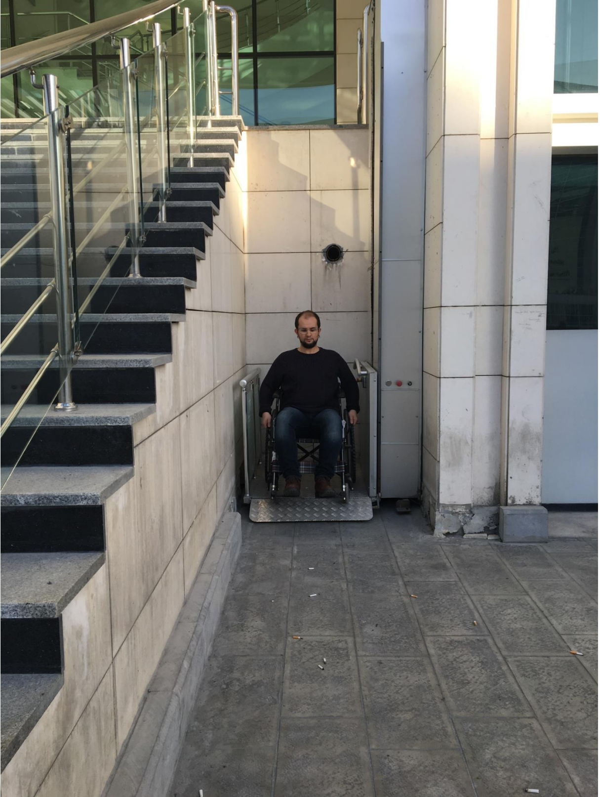
Merdiven asansörü uygulaması, fotoğraf no - 15
