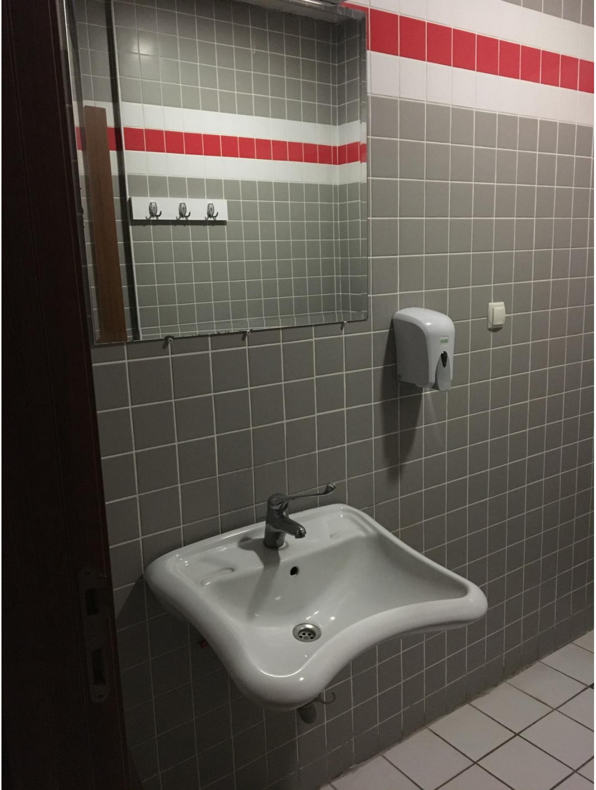
Bina içi uygulamalar - Engelli Tuvaleti, fotoğraf no - 3
