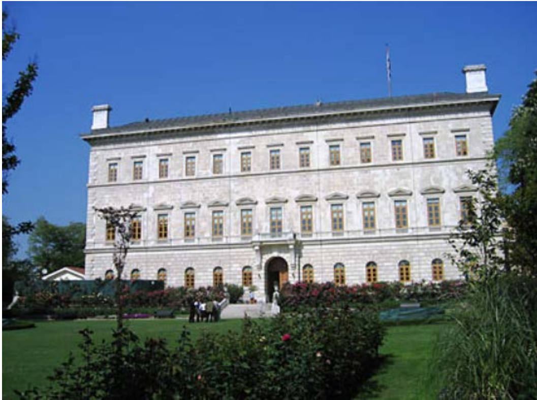
Şekil 31. “İngiltere Konsolosluğu”nun cephe fotoğrafı ( Kamer Hatun Mahallesi, 34435 Beyoğlu/İstanbul)
