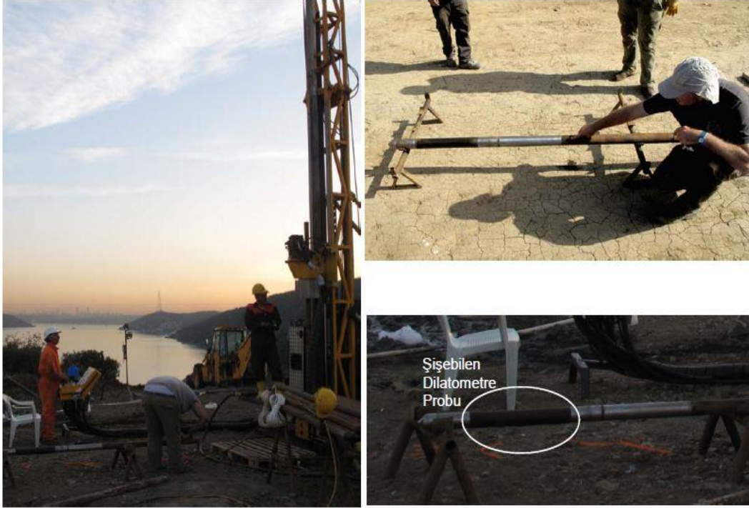
Şekil 2.10. Boğaz Köprüsü proje çalışmaları kapsamında yapılan dilatometre deneyi [33].
