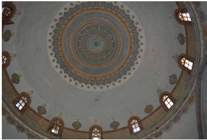
Resim 101: Priştina Sultan Murad Cami Kubbede Bulunan Bezemeler
