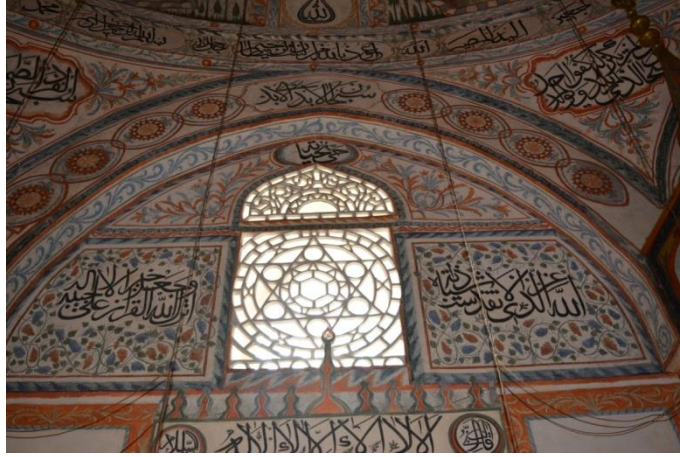
Resim 494: : Hadım Cami Güney Duvarı İkinci Sıra Pencereleerin Etrafındaki Bezemeler
