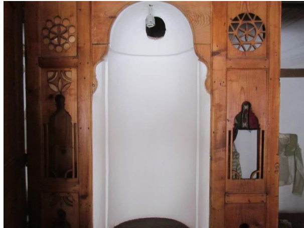
Resim 111: Emincikler Konağı Restorasyon Sonrası Duvar Resminin Silindiği Niş
