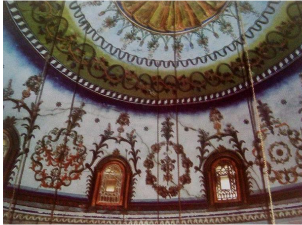
Resim 49: Priştina Yaşar Paşa Cami Restorasyon Öncesi Kubbe (Drançolli, 2011, s. 113)
