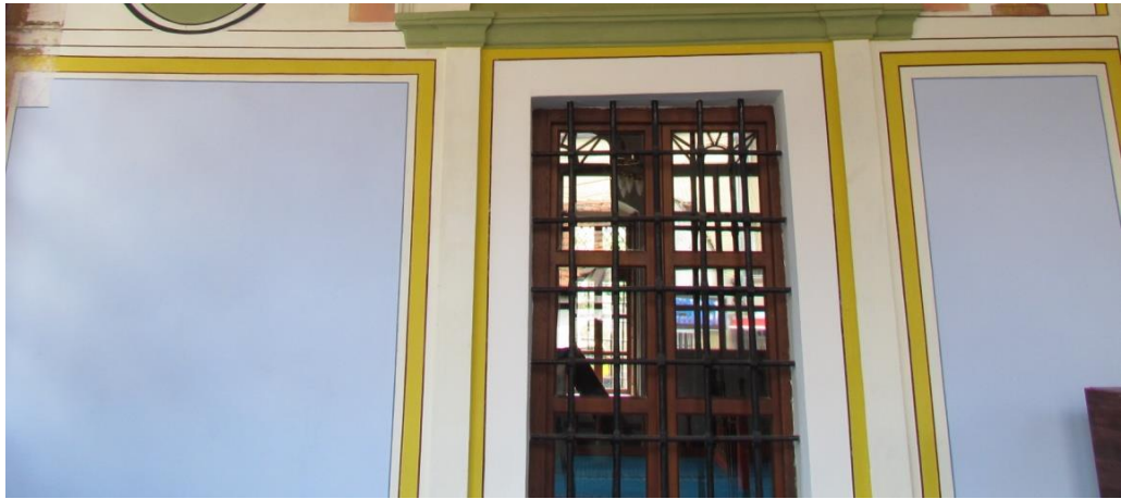
Resim 41: Prishtina Yaşar Paşa Cami Restorasyon Sonrası Son Cemaat Yeri
