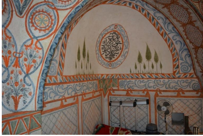
Resim 521: Hadım Cami Hadım Cami Kuzeydoğudaki Trompta Bulunan Bezemeler
