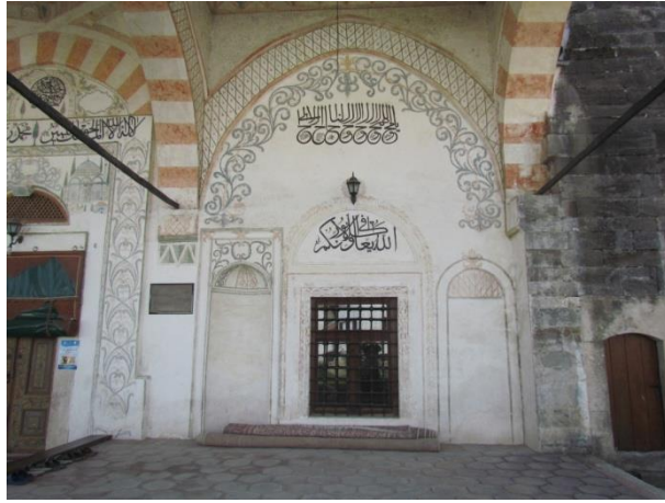
Resim 450: Hadım Cami Son Cemaat Yerinin Sağ Tarafında Bulunan Bölümü
