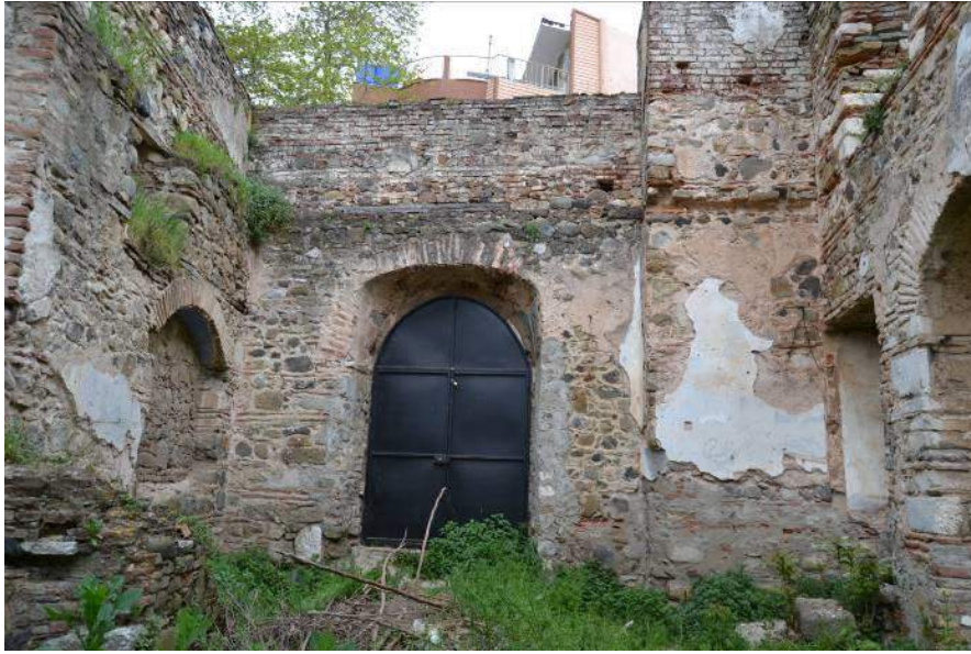
Resim 66. H Mekanının (Giriş Mekanı) Kapısı, Batıya Bakış (2015)
