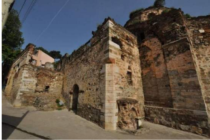
Resim 81. Güney Cephe, Genel Görünüş, Kuzeybatıya Bakış (2015)
