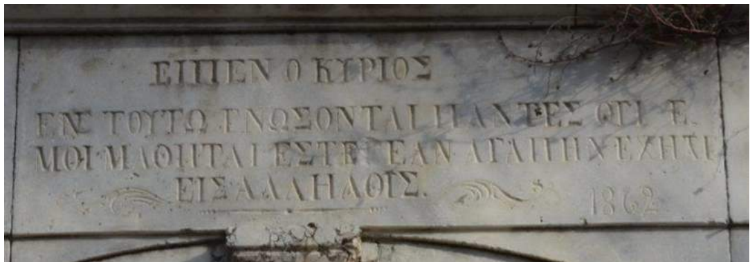
Resim 8. H Mekanının (Giriş Mekanı) Batı Cephesindeki Giriş Kapısının Üstündeki Yazıt, Doğuya Bakış (2015)
