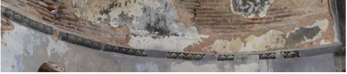
Resim 91. Apsisteki Silme, Güneydoğuya Bakış (2015)
