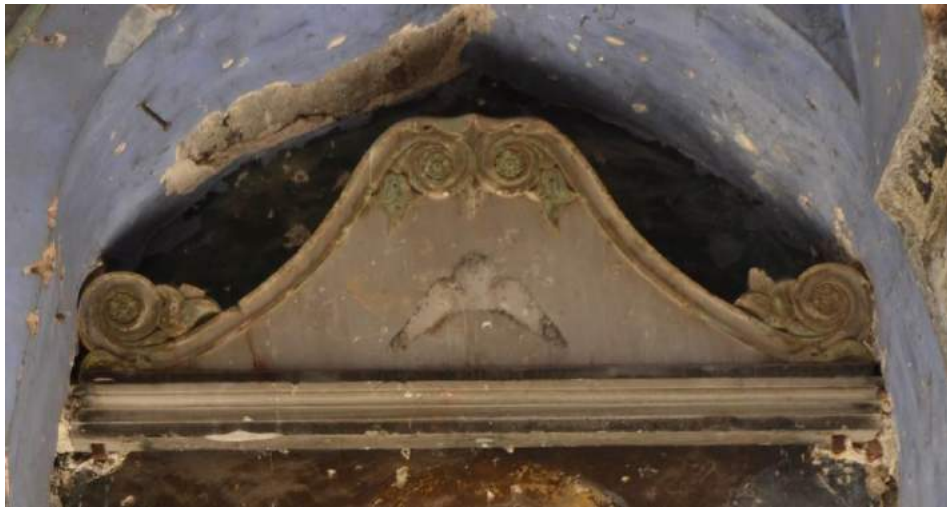
Resim 166. Alınlık, Narteks Kuzey Duvar, Kuzeye Bakış (2015)
