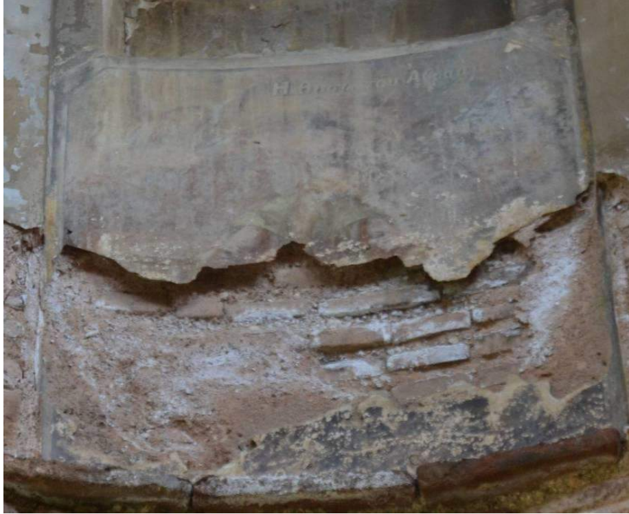
Resim 202. Narteks Kubbe Kasmağı, Kuzey Duvar, İbrahim'in İshak'ı Kurban Etmesi, Kuzeye Bakış (2015)
