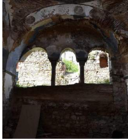
Resim 229. Naos, Kuzey Duvar, Kuzeye Bakış (2015)
