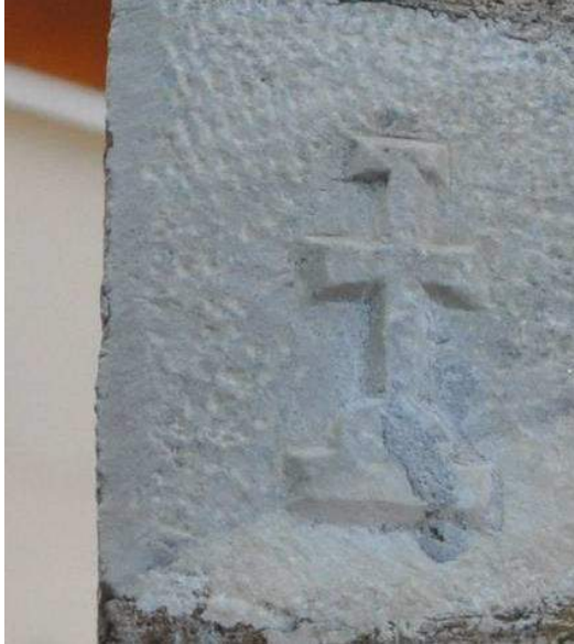
Resim 185. Kazıma Potent Haçı, H Mekanı (Giriş Mekanı) Batı Cephe, Doğuya Bakış (2015)
