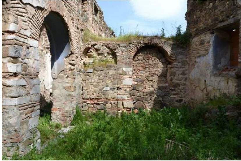
Resim 68. H Mekanı (Giriş Mekanı), Kemerler, Doğuya Bakış (2015)
