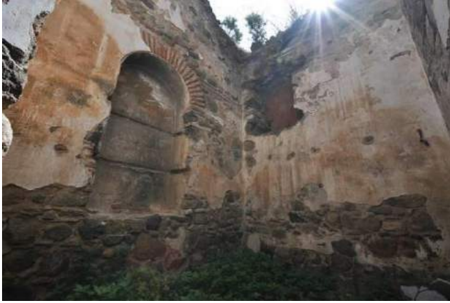
Resim 27. D Mekanı (Kuzeydoğu Mekan), Kuzeydoğuya Bakış (2015)
