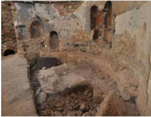
Resim 207. Başmelekler Kilisesi, Synthronon, Kuzeydoğuya Bakış (2015)
