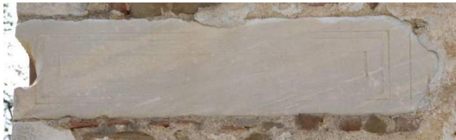
Resim 173. Templon Payesi, H Mekanı (Giriş Mekanı) Doğu Cephe, Batıya Bakış (2015)
