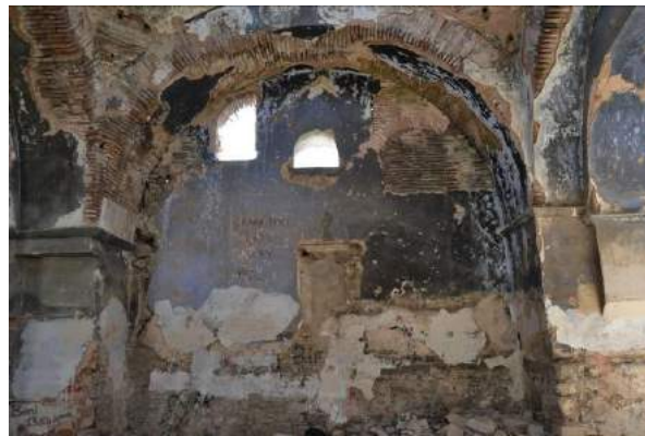
Resim 230. Naos, Güney Duvar, Güneye Bakış (2015)
