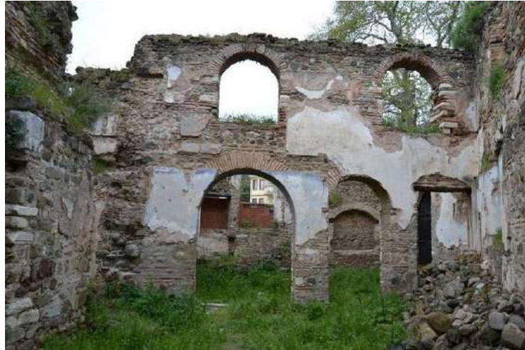
Resim 48. A Mekanı (Eksonarteks), Güney Duvardaki Kapı ve Pencereler, Güneye Bakış (2015)
