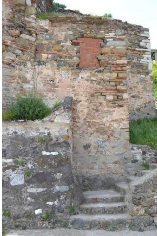
Resim 74. D Mekanının (Kuzeydoğu Mekan) Doğu Cephesi, Batıya Bakış (2015)
