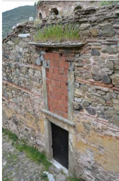
Resim 165. Söve, C Mekanının (Aziz Haralambos Şapeli) Kuzey Cephesi, Güneydoğuya Bakış (2015)
