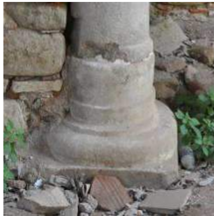
Resim 110. Narteks Güney Duvar, Güneydoğudaki Sütunun Kaidesi, Güneye Bakış (2015)
