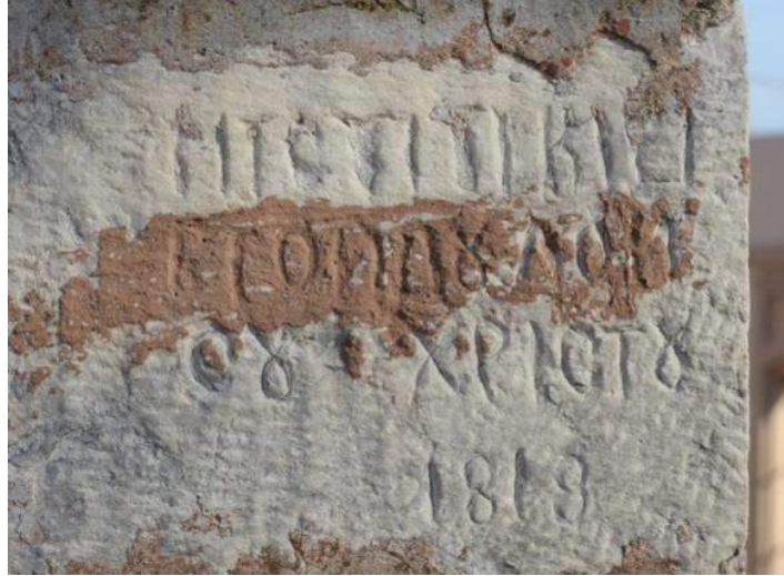
Resim 7. H Mekanının (Giriş Mekanı) Güneybatı Cephesindeki Yazıt, Doğuya Bakış (2015)
