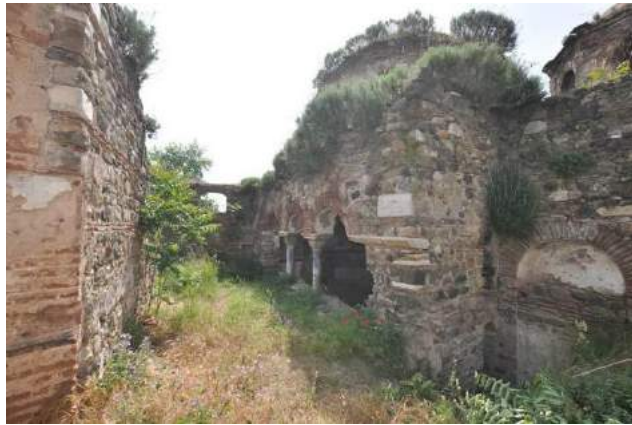
Resim 25. C Mekanı (Aziz Haralambos Şapeli), Güneydoğuya Bakış (2015)
