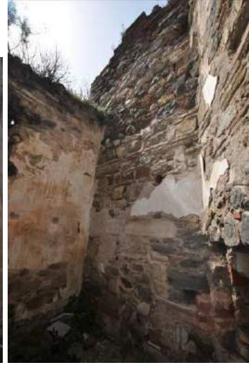
Resim 28. D Mekanı (Kuzeydoğu Mekan), Güneydoğuya Bakış (2015)
