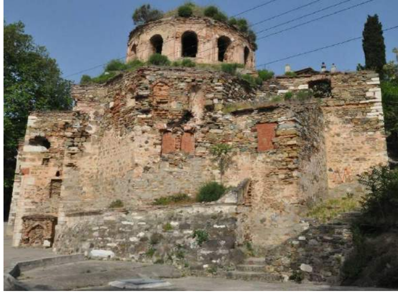
Resim 72. Naos, Apsis, D Mekanı (Kuzeydoğu Mekan) ve C Mekanının (Aziz Haralambos Şapeli) Doğu Cepheleri, Batıya Bakış (2015)
