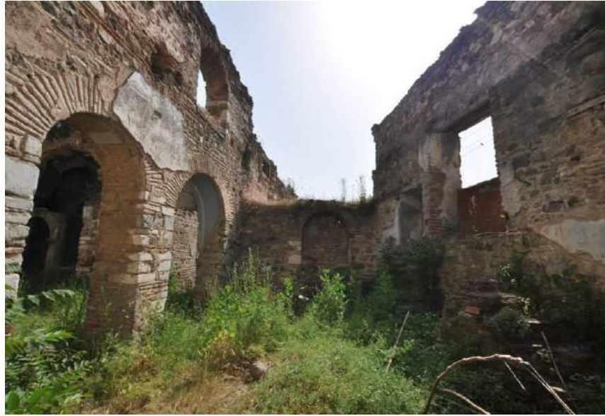
Resim 36. H Mekanı (Giriş Mekanı), Doğuya Bakış (2015)
