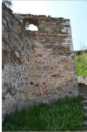
Resim 75. C Mekanının (Aziz Haralambos Şapeli) Doğu Cephesi, Batıya Bakış (2015)
