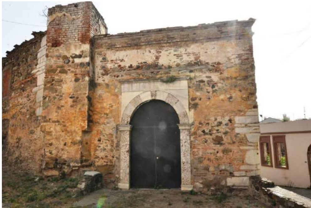
Resim 79. H Mekanının (Giriş Mekanı) Doğu Cephesi, Doğuya Bakış (2015)
