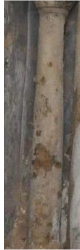
Resim 115. Narteksin Kuzey Duvar, Doğudaki İkiz Sütun Düzenlemesi, Kuzeydeki Sütun, Kuzeydoğuya Bakış (2015)
