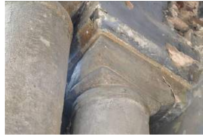
Resim 131. Narteks Kuzey Duvar, İkiz Sütun Düzenlemesi, Kuzeydeki Sütun, Başlığın Güney Yüzü, Kuzeybatıya Bakış (2015)
