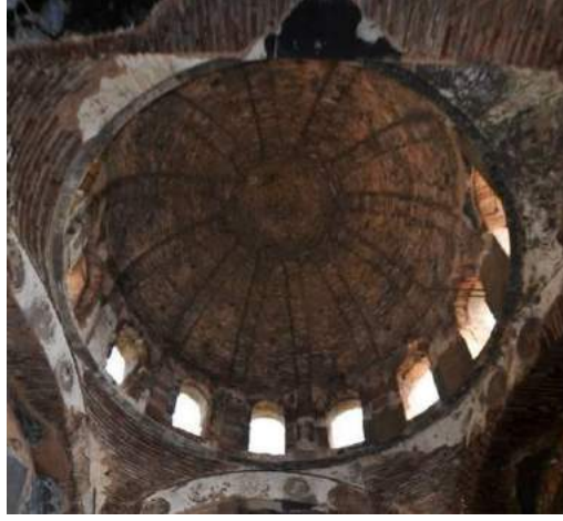
Resim 40. Kubbe Kasnağındaki Pencere, Kuzeye Bakış (2015)
