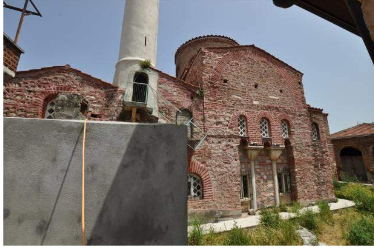
Resim 217. Tirilye Fatih Camisi, Güney Cephe, Kuzeydoğuya Bakış (2015)
