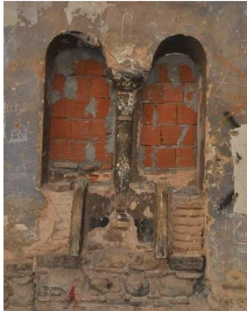
Resim 127. Apsis Doğu Duvar, İkiz Pencere Sütunu, Doğuya Bakış (2015)
