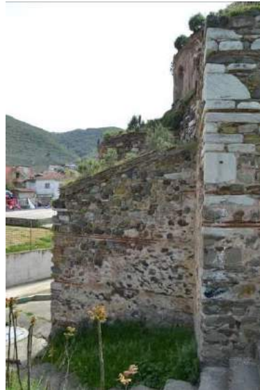
Resim 76. D Mekanının (Kuzeydoğu Mekan) Kuzey Cephesi, Güneye Bakış (2015)
