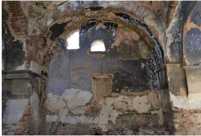
Resim 39. Naos Güney Duvar, Güneye Bakış (2015)
