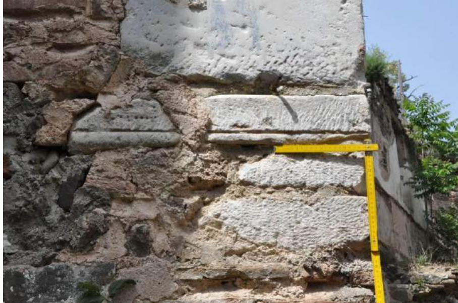
Resim 159. Lento, H Mekanı (Giriş Mekanı) Kuzey Duvar, Kuzeye Bakış (2015)
