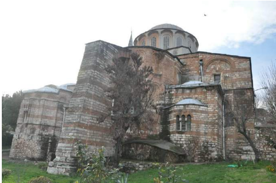
Resim 216. İstanbul Khora Manastırı Kilisesi, Kuzeydoğuya Bakış (2013)
