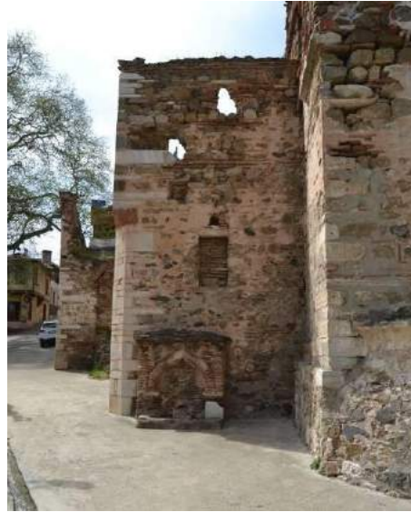
Resim 71. G Mekanının (Aziz Nikolaos Şapeli) Doğu Cephesi, Batıya Bakış (2015)
