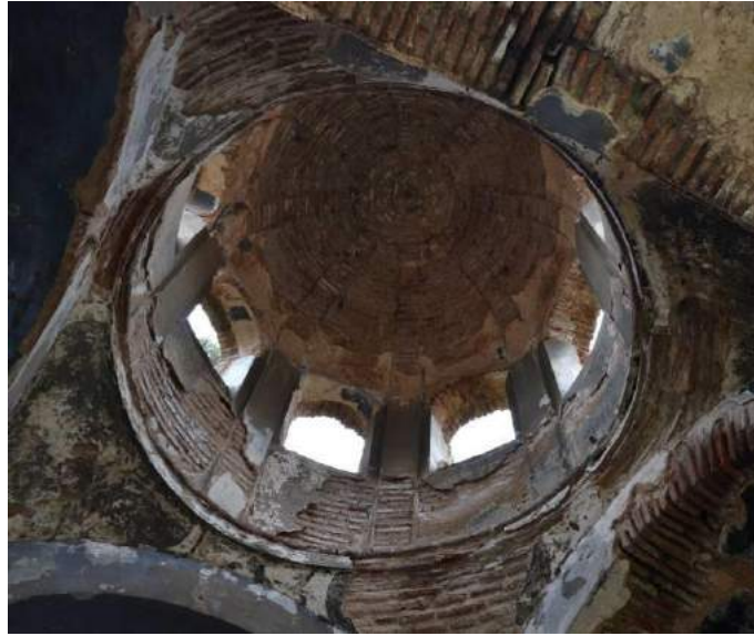
Resim 43. Narteks Kubbe Kasnağındaki Pencereleer, Güneybatıya Bakış (2015)
