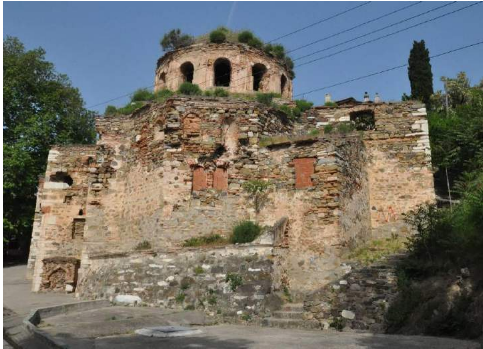
Resim 69. Doğu Cephe Yüzeyleri, Batıya Bakış (2015)
