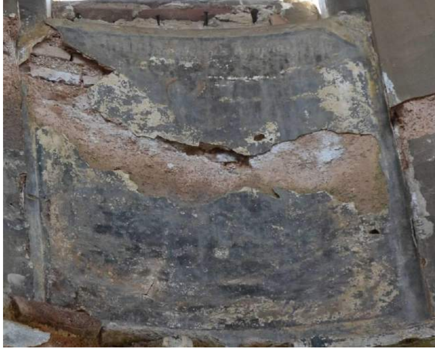
Resim 201. Narteks Kubbe Kasmağı, Güney Duvar, İlk Günah, Güneye Bakış (2015)
