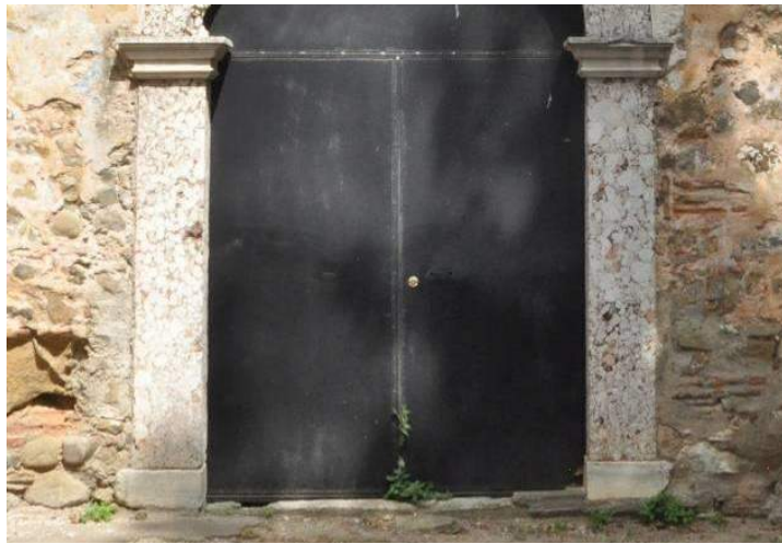
Resim 164. Söve, H Mekanının (Giriş Mekanı) Batı Cephesi, Doğuya Bakış (2015)
