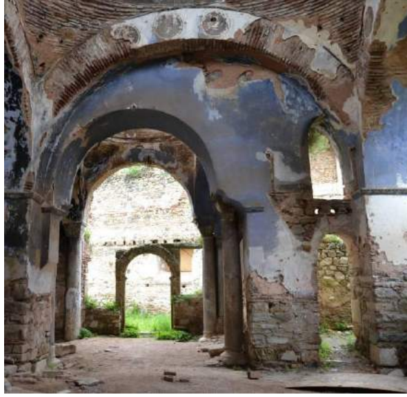
Resim 231. Naos, Batı Duvar, Yarım Yuvarlak Kemerli Pencere ve Yuvarlak Kemerli Kapı, Batıya Bakış (2015)
