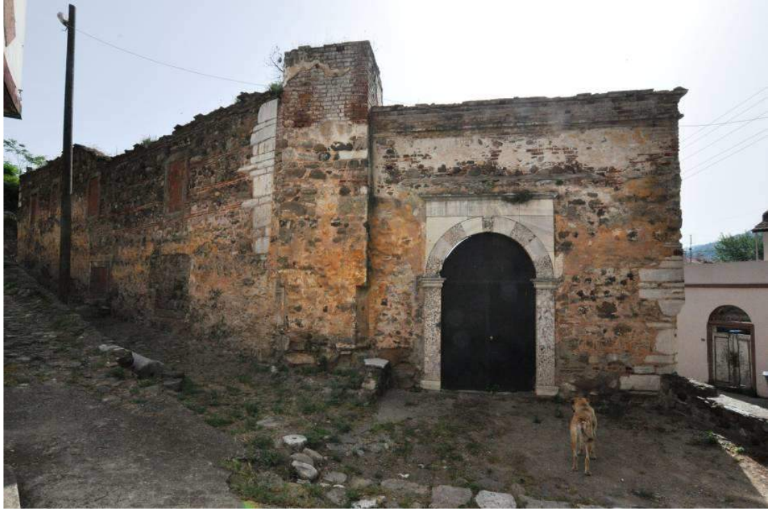
Resim 78. Batı Cephe, Genel Görünüş, Doğuya Bakış (2015)
