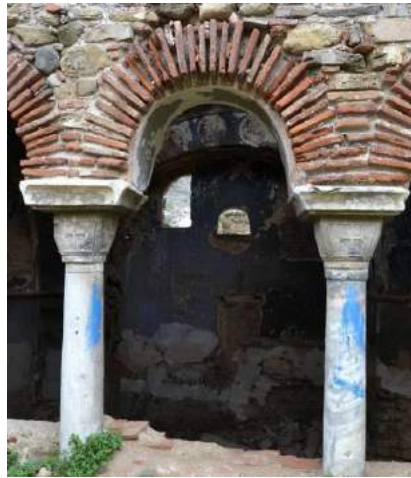
Resim 119. C Mekanı (Aziz Haralambos Şapeli), Üçlü Açıklık, Taşıyıcı Sistemi, Güneye Bakış (2015)
