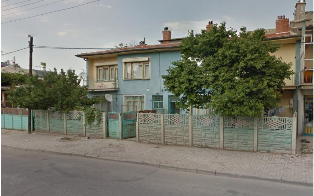
Fotoğraf 3: Mengene Mahallesinde Müstakil Bir Evin Görünümü 1
