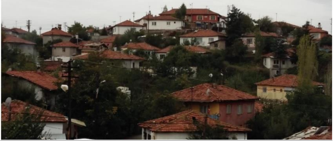
Şekil 39: Dostlar Mahallesi Gecekondu yerleşkesi (Kaynak: Gizem Kulak, 2016)
