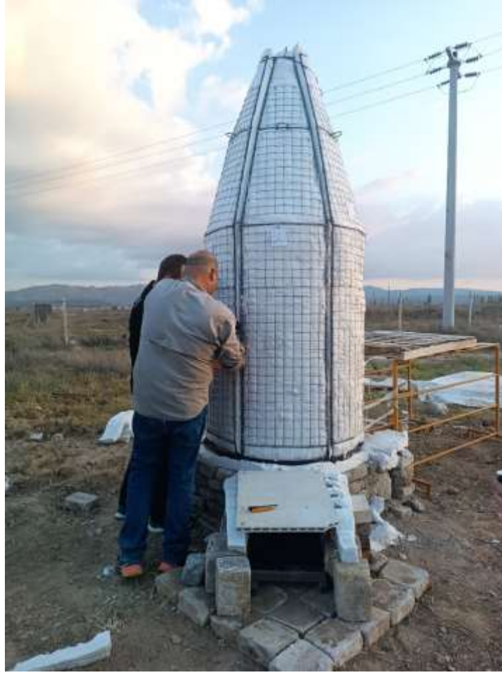
Görsel 102. Montajı yapılan fırının Pişirim öncesi son hazırlıklarının tamamlanması IV Kişisel arşiv
