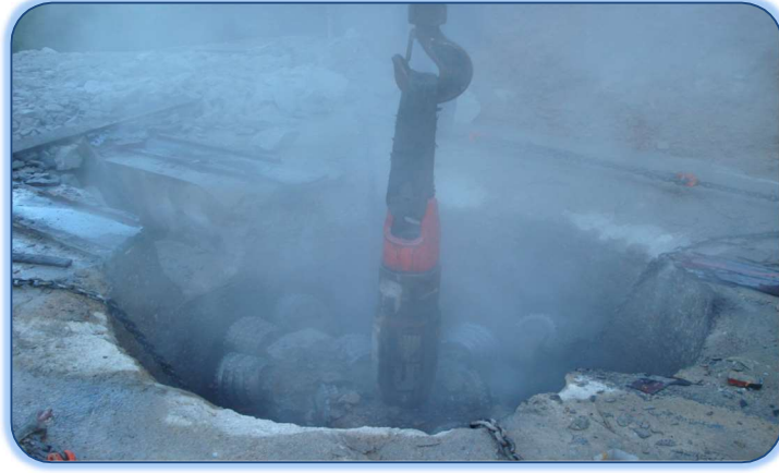
Şekil 4- 34: Tarayıcı kafanın kuyu içinden çıkarılması
