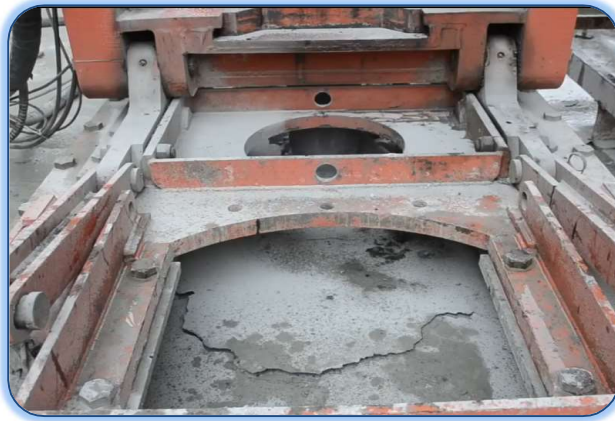
Şekil 4- 33: Tarayıcı kafanın yüzeye çıkarak kazıyı tamamlama anı
