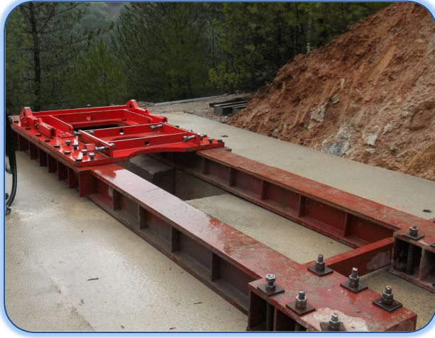
Şekil 4- 26: Kiriş ve platform montajı
