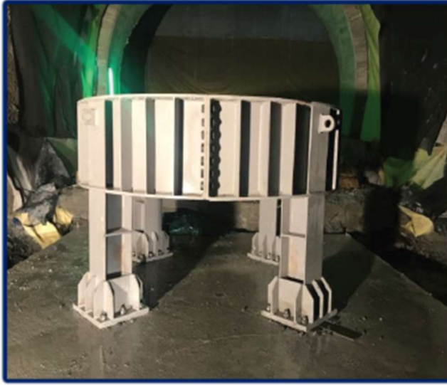
Şekil 7- 15: CTP Boru montajı için kuyu dibinde kurulan sehpa
