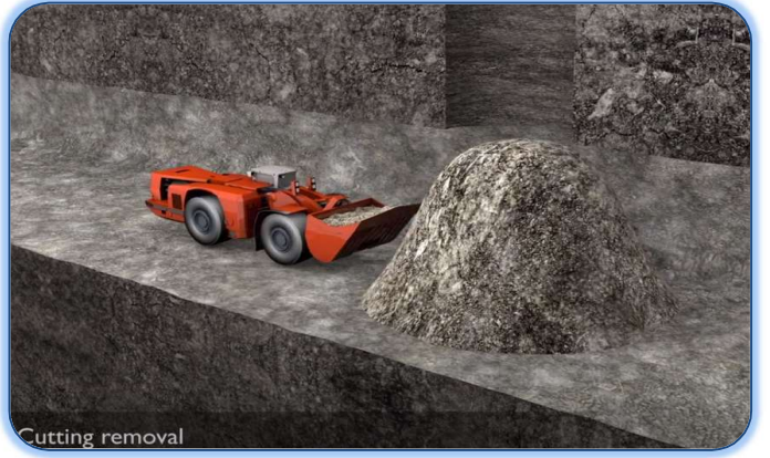
Şekil 4- 32: Kazı sırasında zaman zaman yapılan pasa alma işlemi
