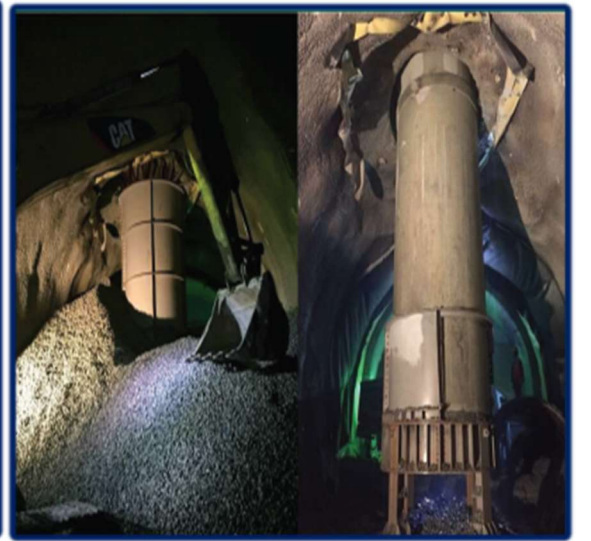
Şekil 7- 16: Kuyu içine boru kaplama yapılıncaya kadar duraylılık sağlaması için doldurulan agreganın boşaltılarak boru montajının yapılması
