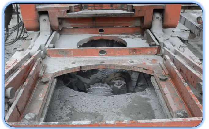
Şekil 4- 33: Tarayıcı kafanın yüzeye çıkarak kazıyı tamamlama anı
