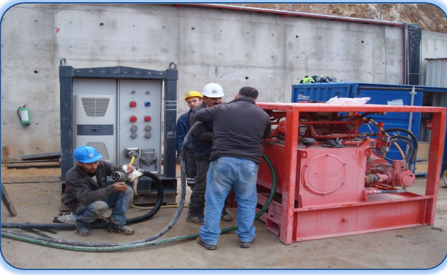
Şekil 4- 26: Elektrik ve hidrolik güç üniteleri bağlantısı
