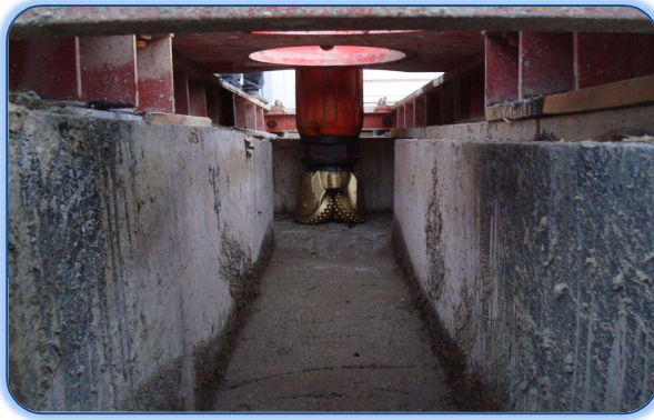
Şekil 4- 28: Kılavuz delgi aşaması
