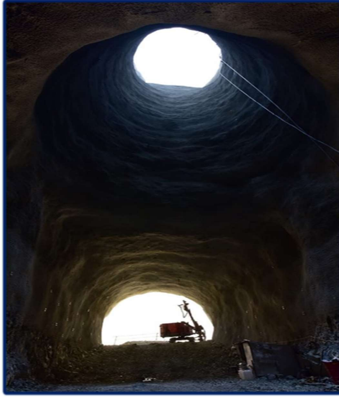
Şekil 7- 23:Yusufeli Barajı su alma kuyusu aşağıdan görünüm
