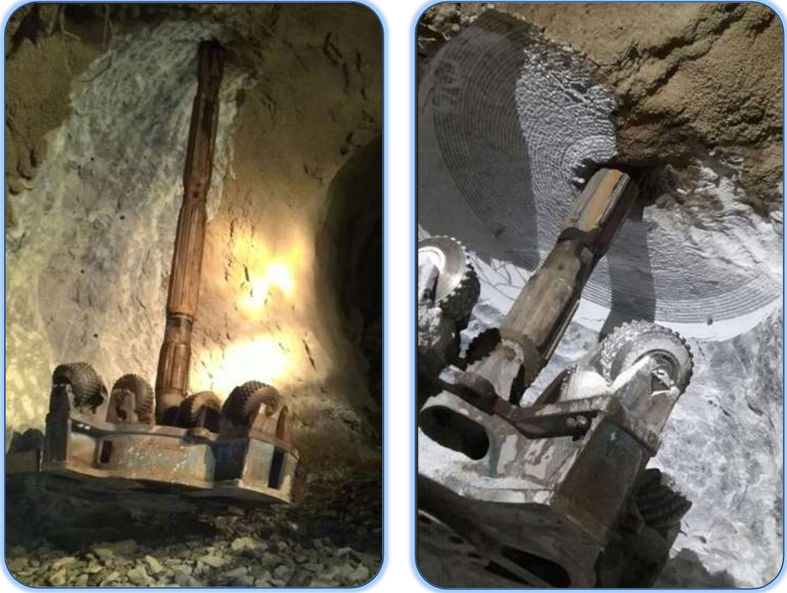
Şekil 7- 4: Tarayıcı kafanın montajı ve kazının yuva oluşturma aşaması
