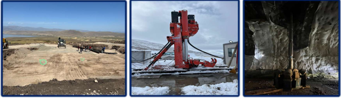
Şekil 7- 18:Sırasıyla platform kazısı, kurulum, tarayıcı kafa montajı
