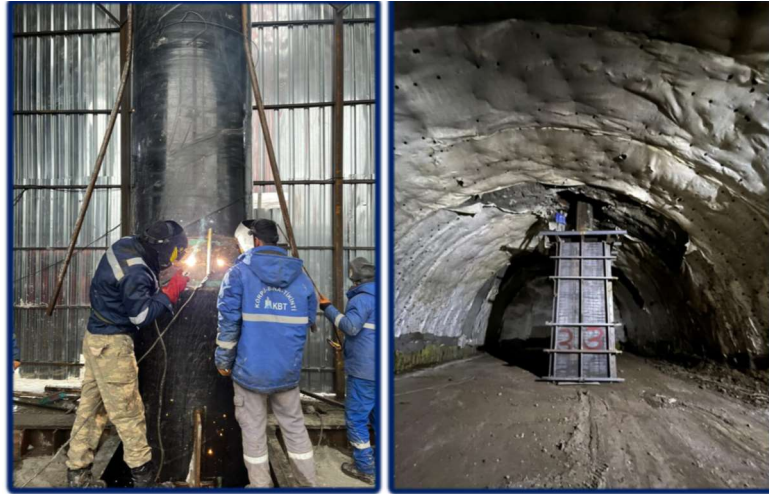
Şekil 7- 20:Sırasıyla boruların birbirine kaynak edilmesi, kuyu dibine kurulan çelik sehpa ve kılıf
