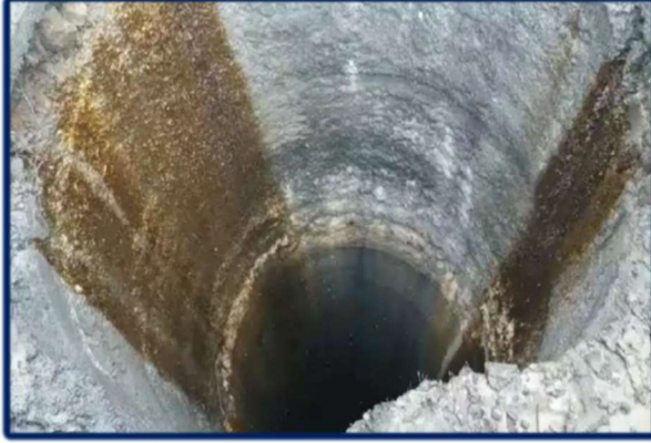
Şekil 7- 13: Havalandırma kuyusu: 3,60m çap
