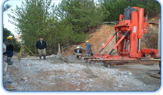
Şekil 4- 31: Kurulum sonrası koordinat kontrolü
