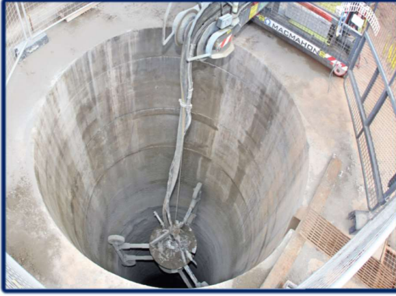
Şekil 7- 10: Robotik Püskürtme Beton Uygulaması [43]
