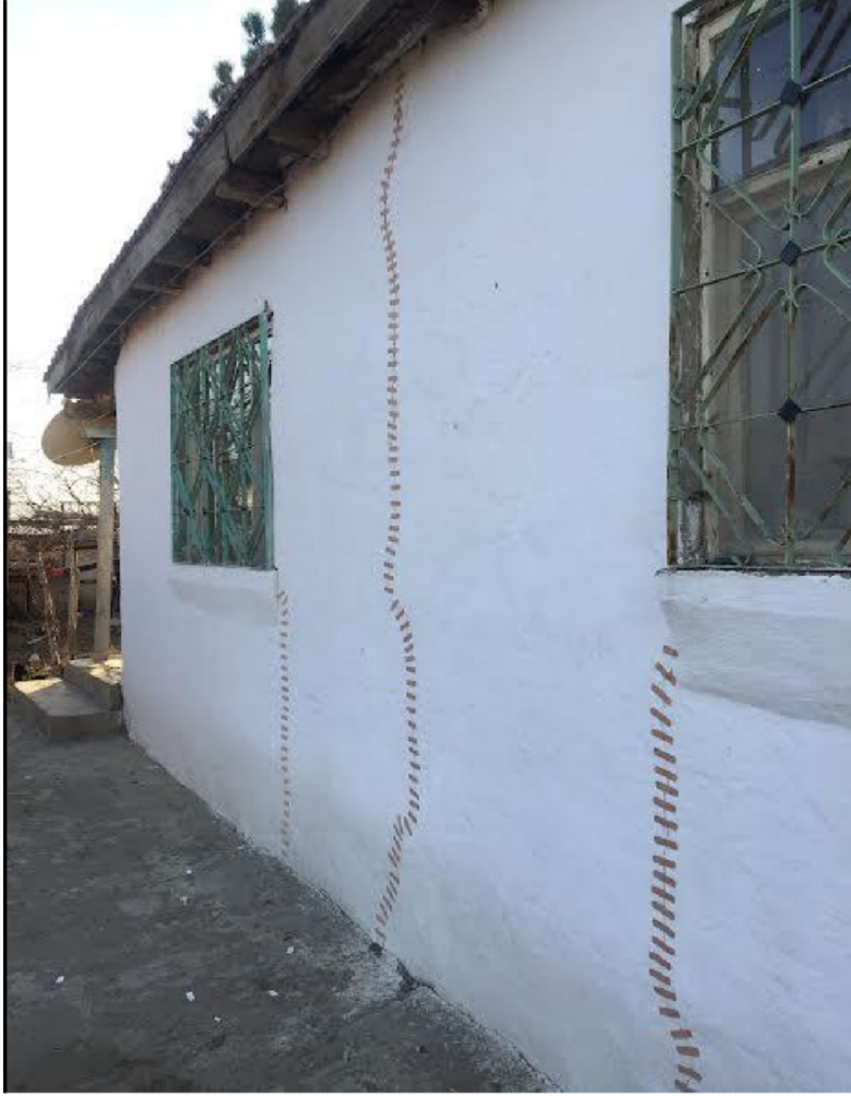
Görse 27. Selda Yurtsever, 2022, Onarım, (enstalasyon, duvar çatlakları, yara bandı, deęişken boyut).
