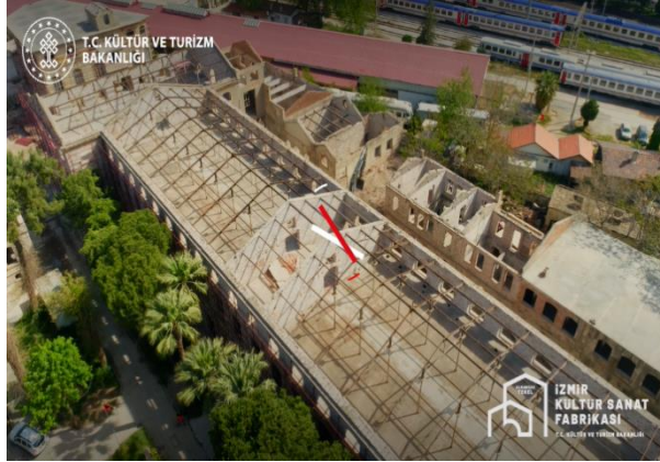
Şekil 8: Fabrika'nın Restorasyon Süreci
