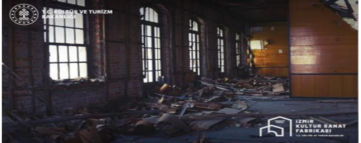
Şekil 5: Fabrika'nın Atıl Kaldığı Dönemden İç Cephe Görünümü
