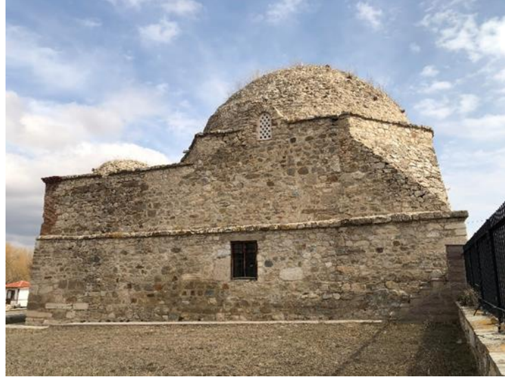
Fotoğraf 32. Hamamkarahisar Cami Batı Cephesi
