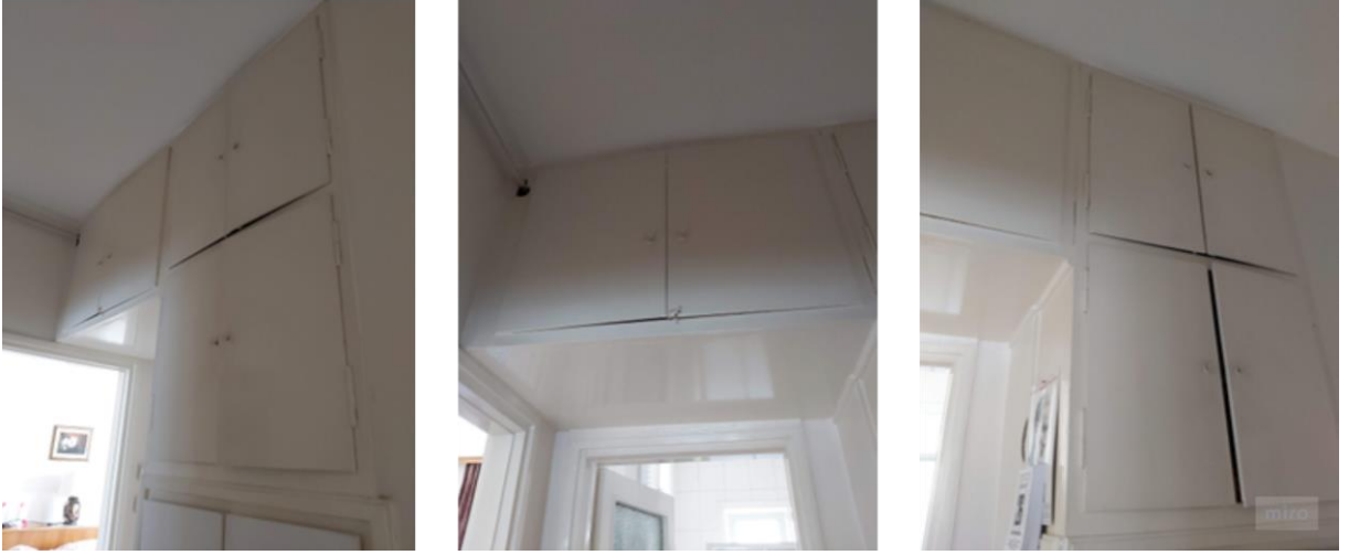
Görsel 27. Kolidorda bulunan sabit depolamaya daha sonra yapılan eklenti (Yazarın kişisel arşivi)
