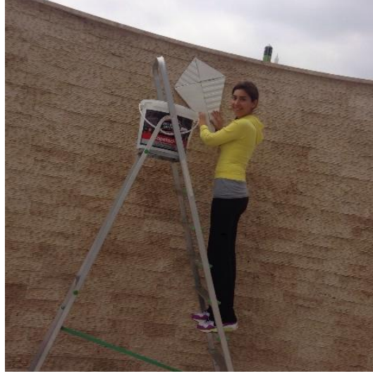
Görsel 18. Tekno Park Duvarına Seramik Modüllerin Montajı. Kaynak: Kişisel Arşiv, 2014.
