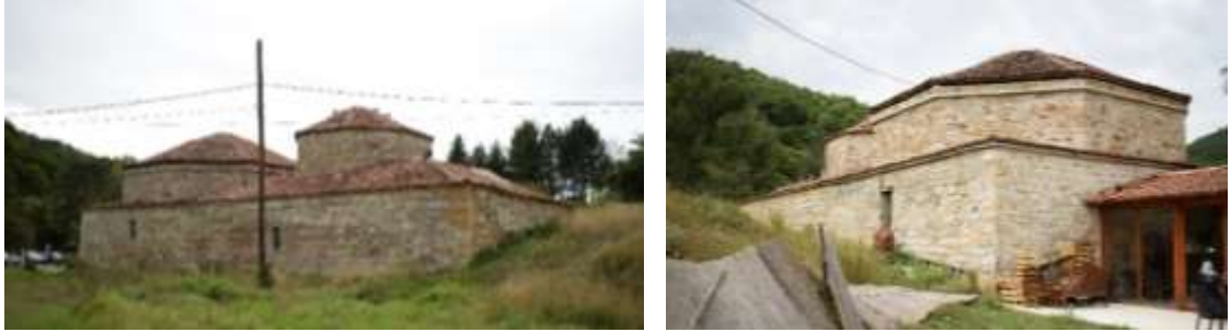
Fotoğraf 216. Novi Pazar Kaplıcası'ndaki Hamam (1593/1594), Güney-batı ve Güney-doğu Cephe (Sol) ve Kuzey-doğu Cephe (Sağ)
