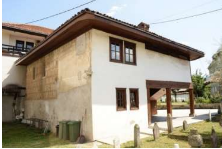
Fotoğraf 65. Altun-Alem Mektebi (16. Yüzyıl), Batı (Sağ) ve Kuzey (Sol) Cephe
