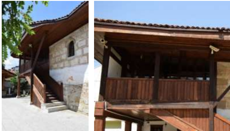
Fotoğraf 66. Altun-Alem Mektebi (16. Yüzyıl), Ana Cephe'deki Merdiven ve Hayat
