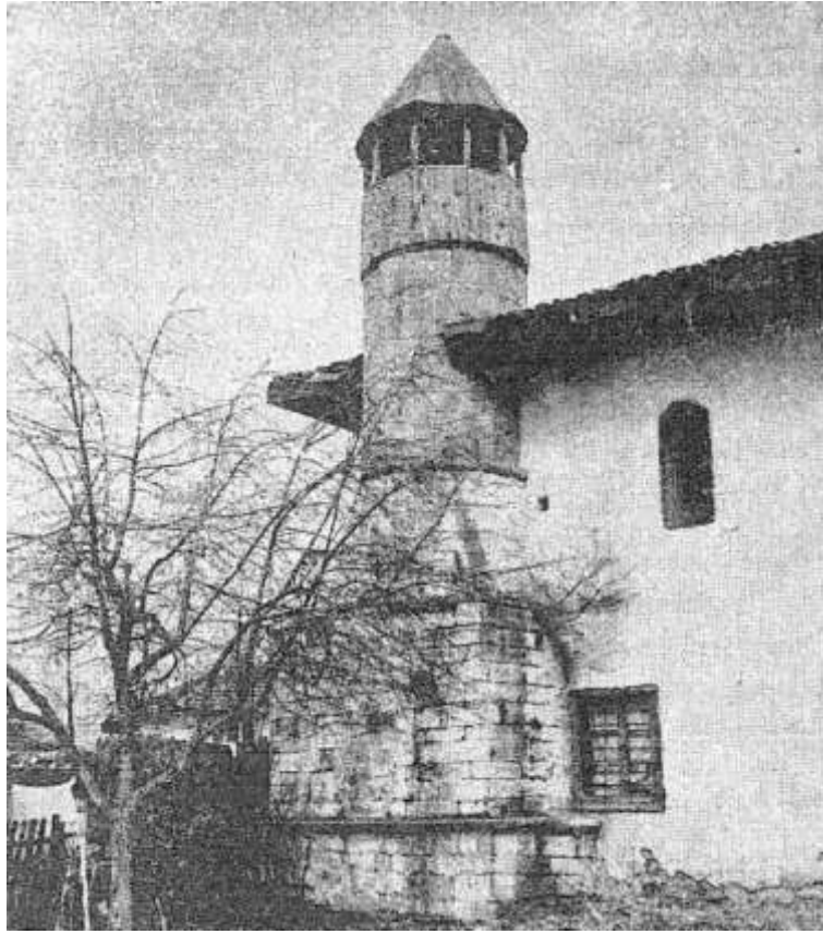
Fotoğraf 125. Kurt Çelebi Camisi (16. Yüzyıl), 1992 Yılında Güneybatı Cephede Minare
