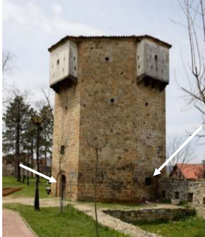
Fotoğraf 25. Gözetleme Kulesi (1717?), Giriş Kapısı ve Kapatılmış Pencere
