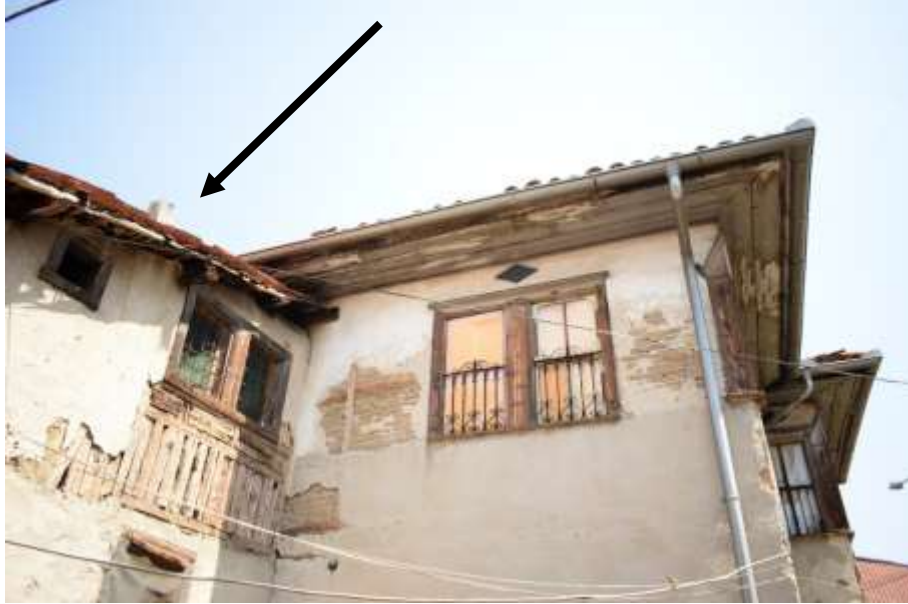
Fotoğraf 256. Hamzagić Konağı (1910), Batı Cephedeki Ek Yapı
