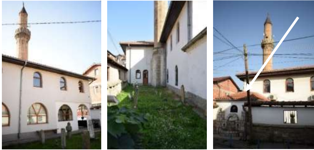
Fotoğraf 116. Bor Camisi (1561), Kuzeybatı, Güneybatı ve Güneydoğu Cephe (Soldan Sağa)
