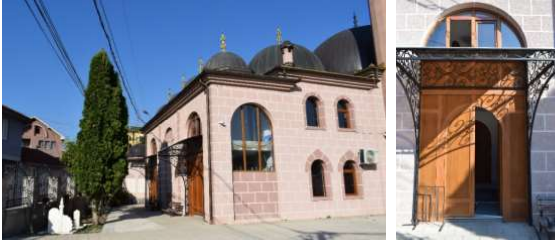
Fotoğraf 126. Kurt Çelebi Camisi (16. Yüzyıl), Kuzeybatı Cephe ve Giriş Kapısı
