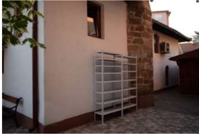
Fotoğraf 101. Çalapverdi Camisi (16. Yüzyıl), Güneybatı Cephe
