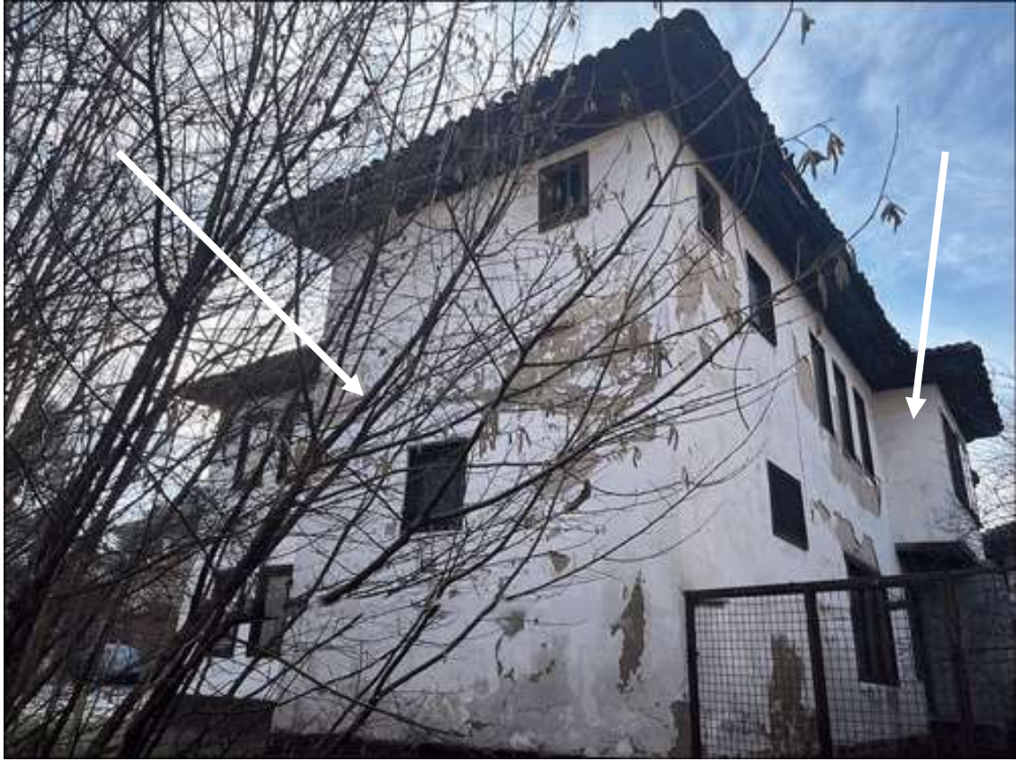
Fotoğraf 249. Komatina Konağı (1908), Doğu (Sol) ve Kuzey (Sağ) Cephe
