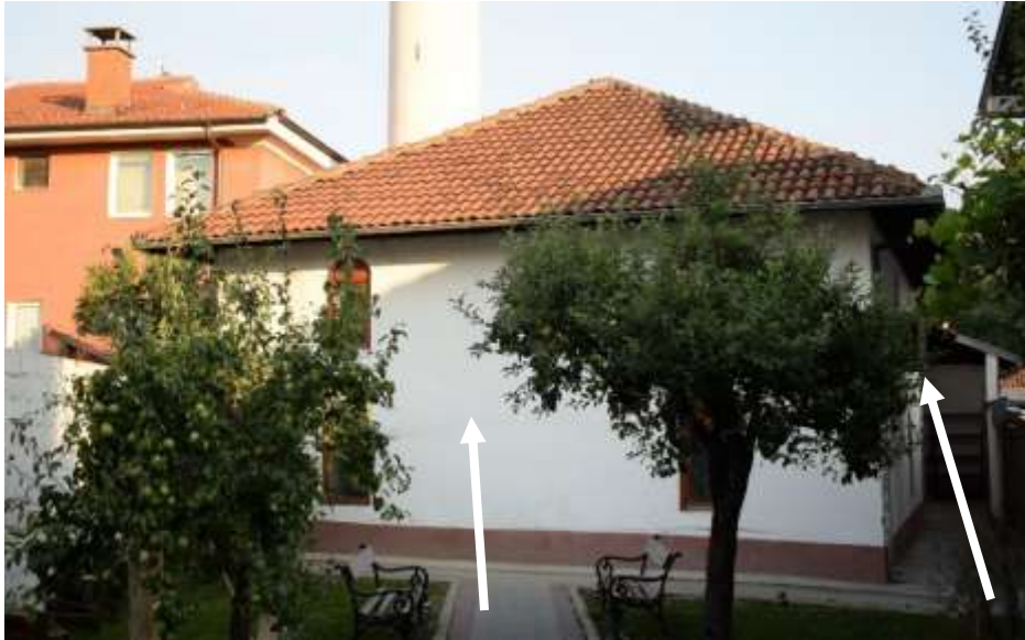
Fotoğraf 100. Çalapverdi Camisi (16. Yüzyıl), Güneydoğu (Sol) ve Kuzeydoğu (Sağ) Cephe
