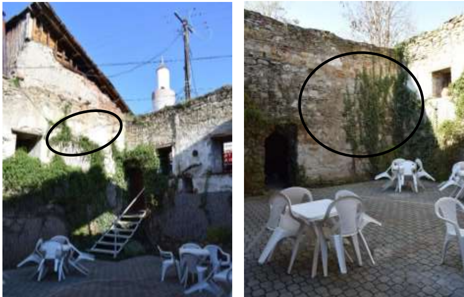
Fotoğraf 201. Gazi İsa Bey Hamamı (15. Yüzyıl), Kadın Soğukluk Kısımındaki Duvarlar
