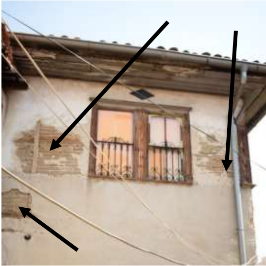
Fotoğraf 252. Hamzagić Konağı (1910), Batı Cephedeki Tuğla ve Kiriş
