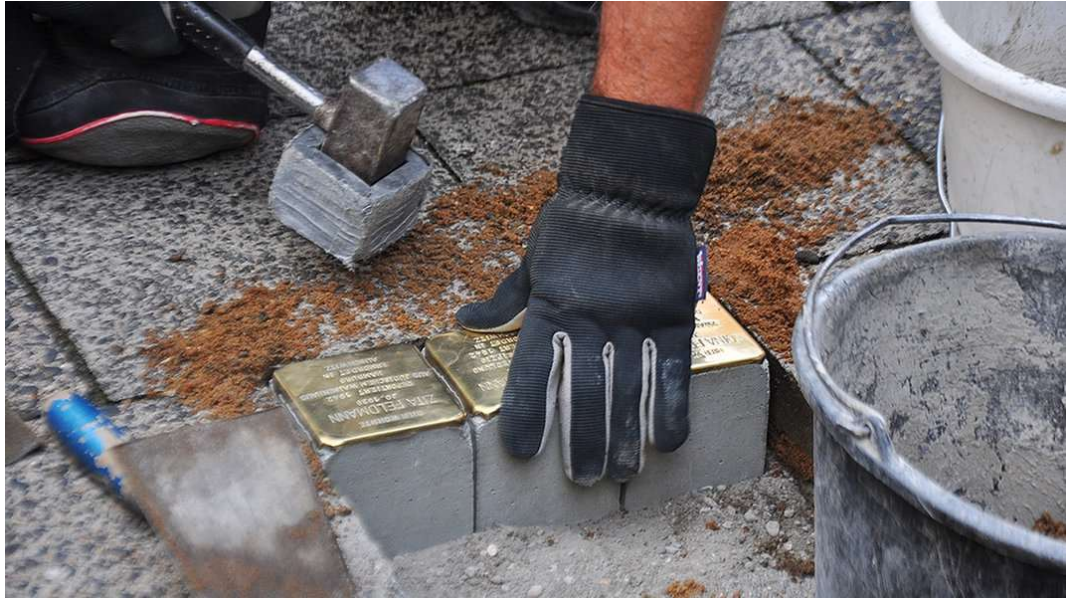
Görsel 40: Tökezleten Taşların Kaldırma Eklenmesi 44
