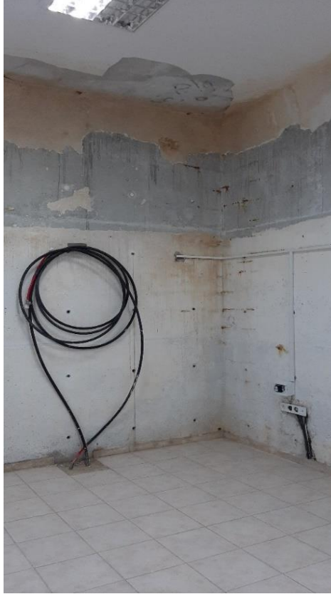
Görsel 61. Fikret Otyam Sanat Merkezi, Mevcut Yapı Elemanı (Kişisel Arşiv, 2023).
