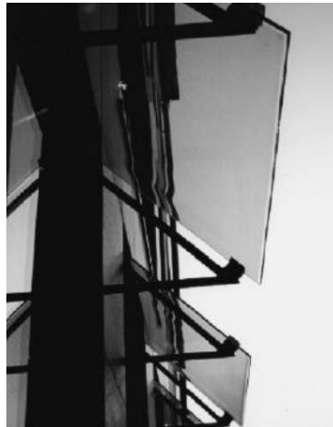
Grsel 68. Holografik Optik Eleman Pencere st Uygulama. (Erel, 2004, s. 60).
