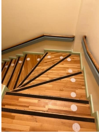
Görsel 13. Ayser Ve İhsan Doğramacı Anaokulu Yemekhanesine İnen Merdivenler
