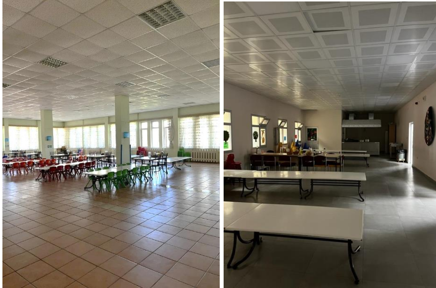
Görsel 23. Beytepe Anaokulu Ana Binası Yemekhanesi (sağda) Beytepe Anaokulu Ek Binası Yemekhanesi (solda)
