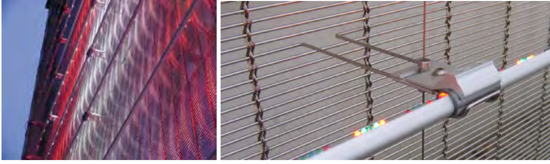
Görsel 45. Binanın dış cephe kaplaması olarak kullanılan Illumesh ve detay görünümü. (Kaynak: Fritz, S. (2009). Media Façade. Erişim: 30.04.2023. https://www.architonic.com/fr/story/susanne-fritz-media-facade/7000408 .)
