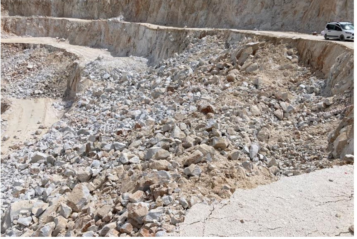
Şekil 3.14. Çift yemleme yapılan patlatma sonrası
