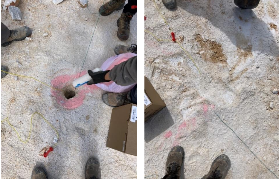
Şekil 3.9. İkinci yemleyicinin yerleştirilmesi (solda) ve şarjlanmış ölçüme hazır delik (sağda)
