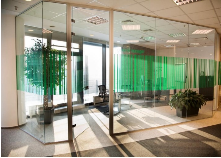
Şekil 80. şeffaf cam bölme panellerin kullanımıyla gün ışığı yansımaları derin iç mekanlara doğru yönlendirilmektedir (ABC Movable Building Systems, 2023).
