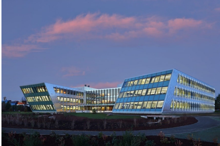
Şekil 60. Federal Merkez Güney Binası (ZGF, tarih yok).
