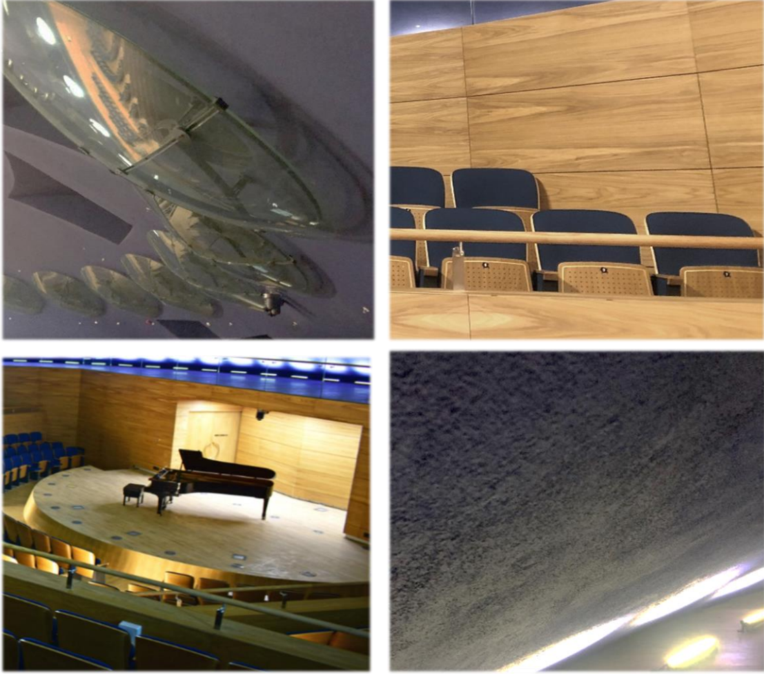
Görsel 66. Oda Müziği Salonu İç Mekân Yüzeylerinde Akustik Yapılanma (Kişisel arşiv)
