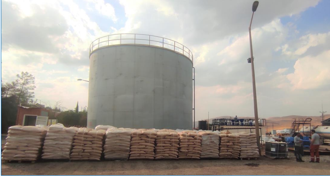
Şekil 3. 35. Operasyon öncesi GZ kamp alanına yapılan ilk nakliyatta ulaştırılan AAm paletleri ve CrAc varilleri
