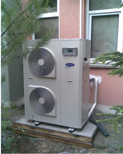
Şekil.1 Hava kondenserli su soğutma grubu ve su soğutma sistemi
