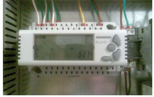
Şekil.3 Açma-kapama düğmeleri ve pano içerisindeki sıcaklık kontrolcüsü
