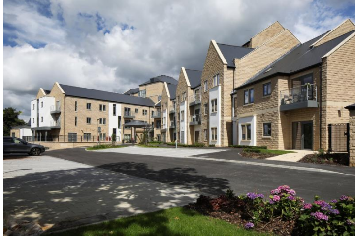
Görsel 18 Fern House Dementia Care. Dış Cephe Görünümü. (Abbeyfield) https://bit.ly/3n5FbnX
