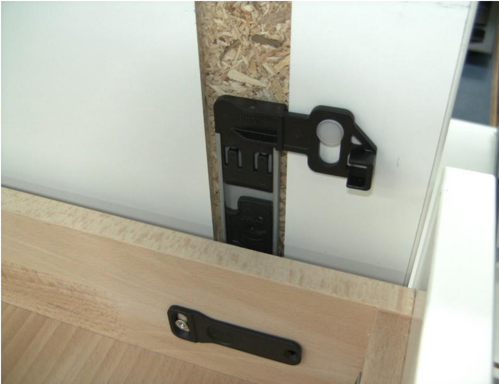
Resim 3.20 Ahşap kaplamalı çekmece sistemi bağlantı resmi [17]
