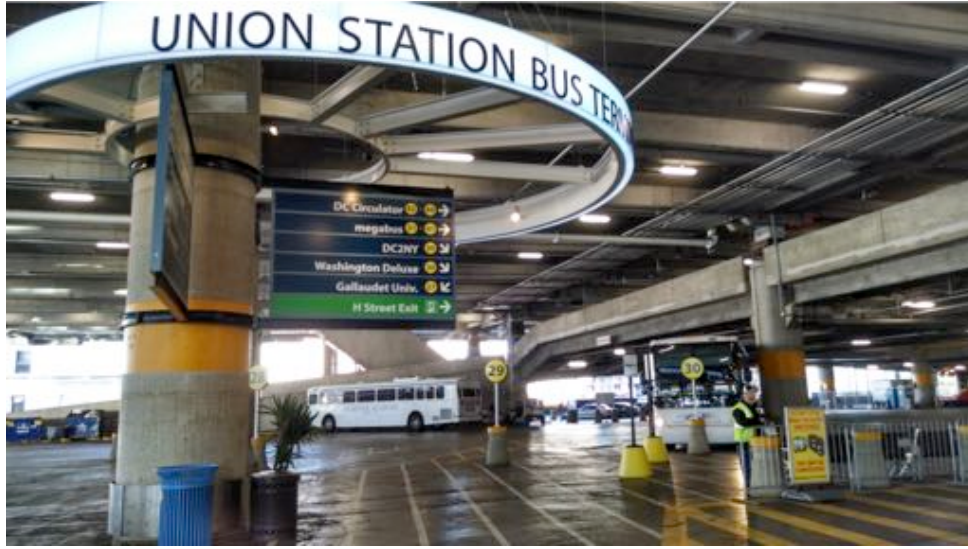
Görsel 85. Union İstasyonu Otobüs Terminali Dış Mekan Yönlendirme Levhaları ( http://evolvingpf.com/2014/10/first-trip-megabus/ )
